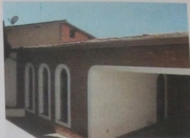
Vista da fachada do imóvel da Rua Ermênio de Oliveira Penteado, n ° 338
