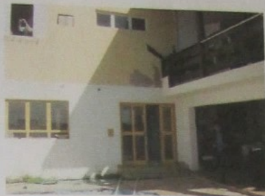
Vista dos fundos do imóvel da Av. Lafayette de Arruda Camargo, n° 667
