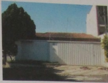
Vista da fachada do imóvel da Rua Ermênio de Oliveira Penteado, n ° 338
