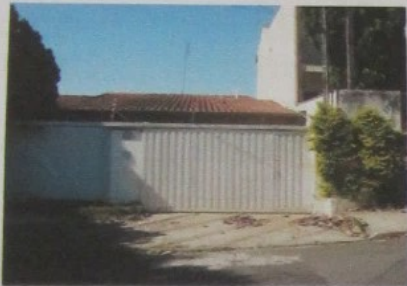
Vista da fachada do imóvel da Rua Ermênio de Oliveira Penteado, n ° 338
