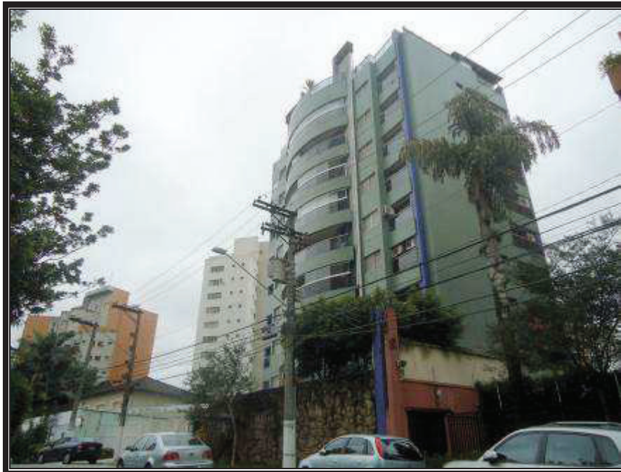
Vista da Torre B do Condomínio Edifício The Península.
