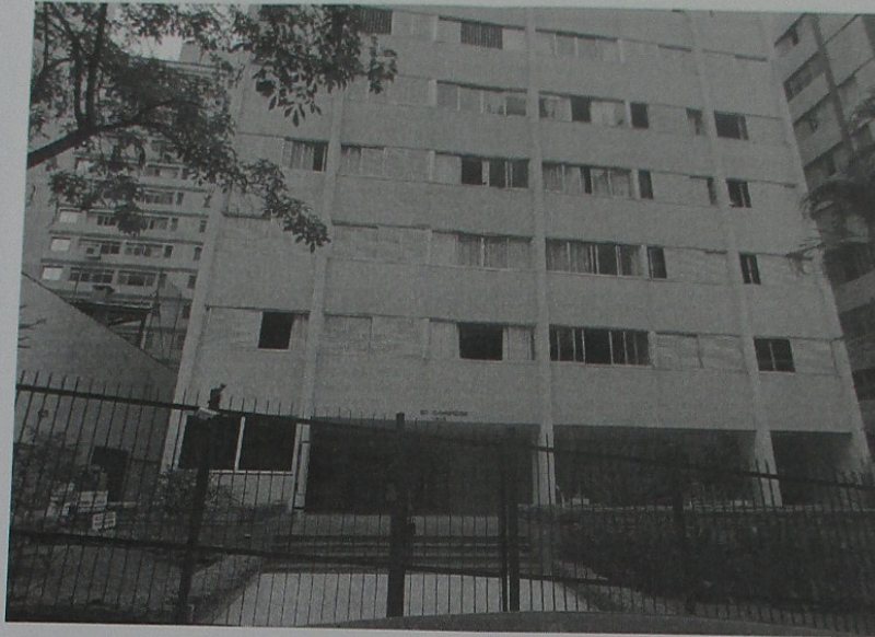
Figura 2 – Fachada do Edifício Cambridge
