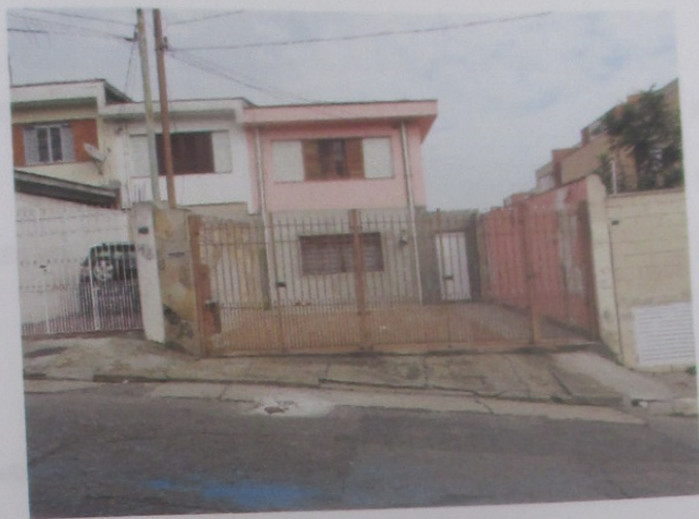
Fachada do Imóvel Avaliando
