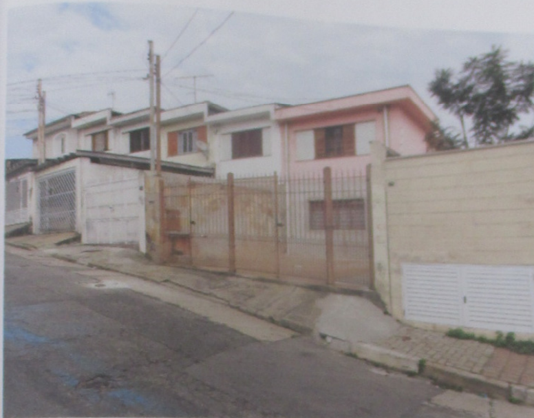
Fachada do imóvel avaliando
