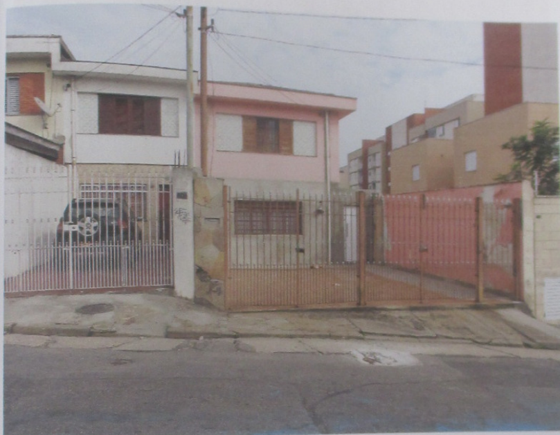
Fachada do imóvel avaliando
