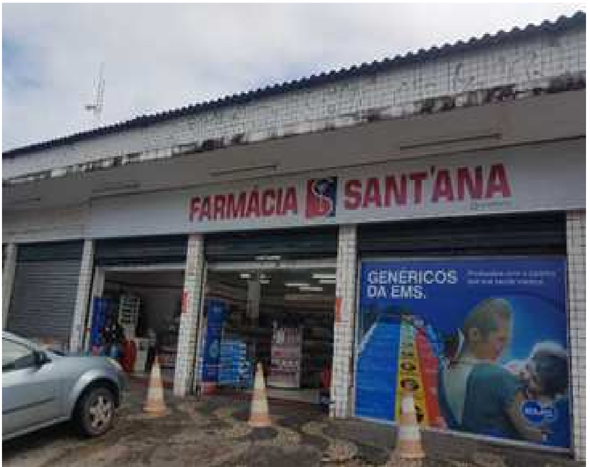
Vista do Ponto Comercial do Imóvel XLVII, localizado na Avenida Dom João VI, nº 486, Bairro Brotas, Salvador, Bahia.
