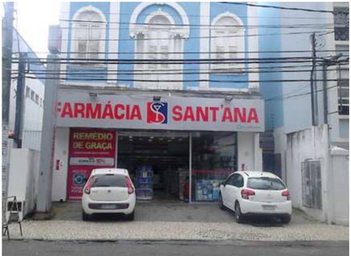
Vista do Ponto Comercial do Imóvel LIII, localizado na Rua da Graça, n° 22, Bairro Graça, Salvador, Bahia.
