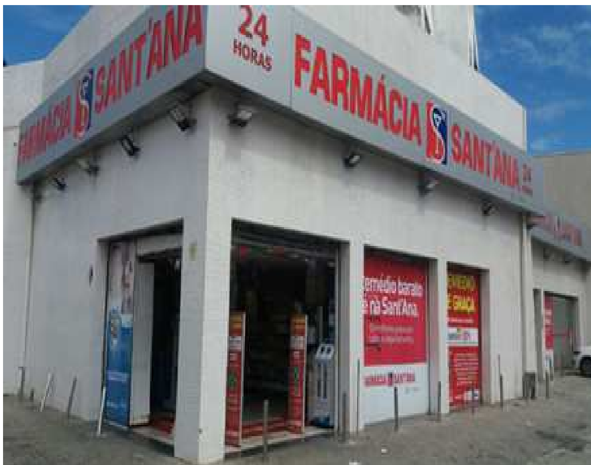
Vista do Ponto Comercial do Imóvel XLIX, localizado na Avenida Manoel Dias da Silva, nº 1974, Bairro Pituba, Salvador, Bahia.
