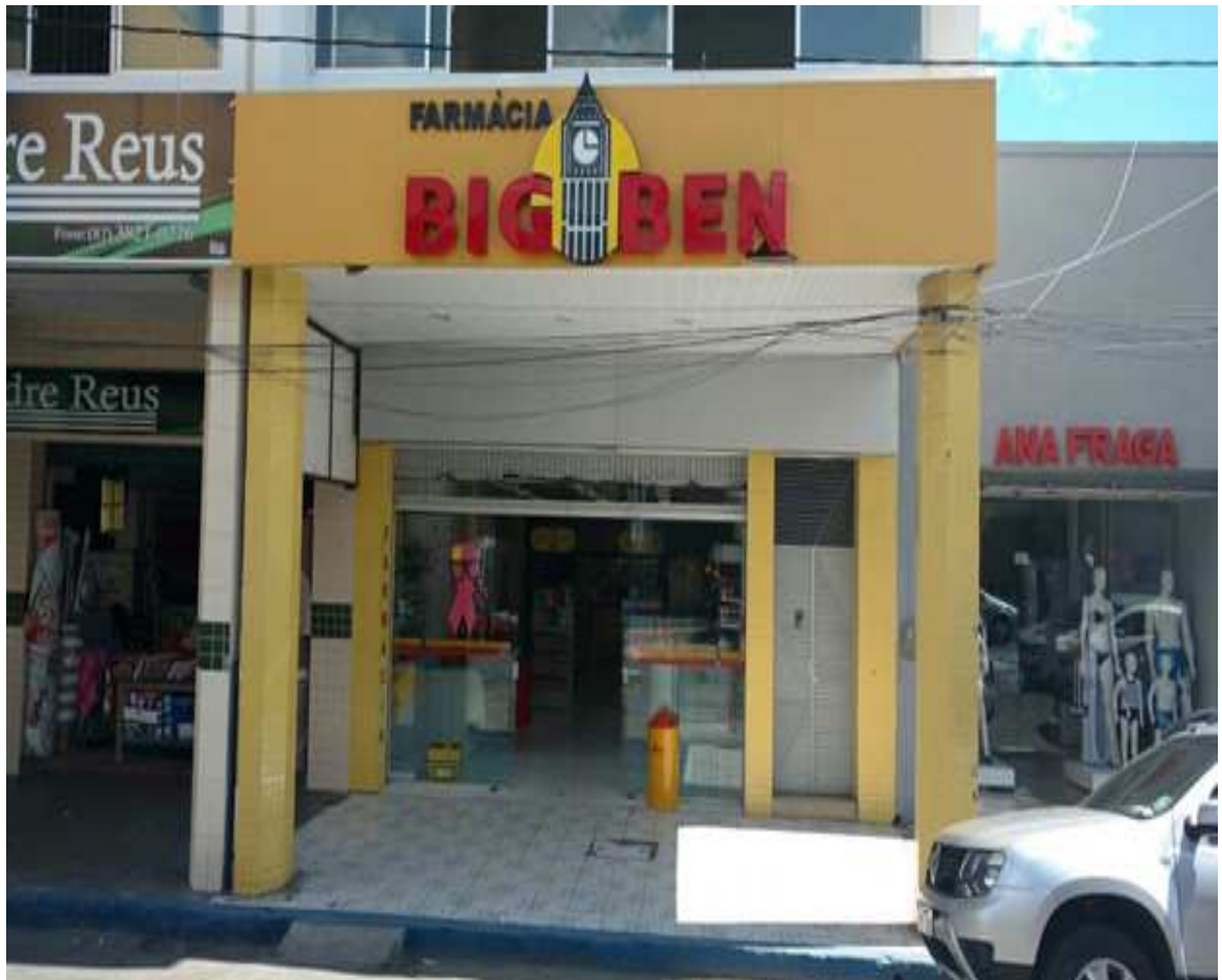
Vista do Ponto Comercial do Imóvel XLVI, localizado na Avenida Coronel Antonio Japiassu, nº 507, Bairro Centro, Arcoverde, Pernambuco.
