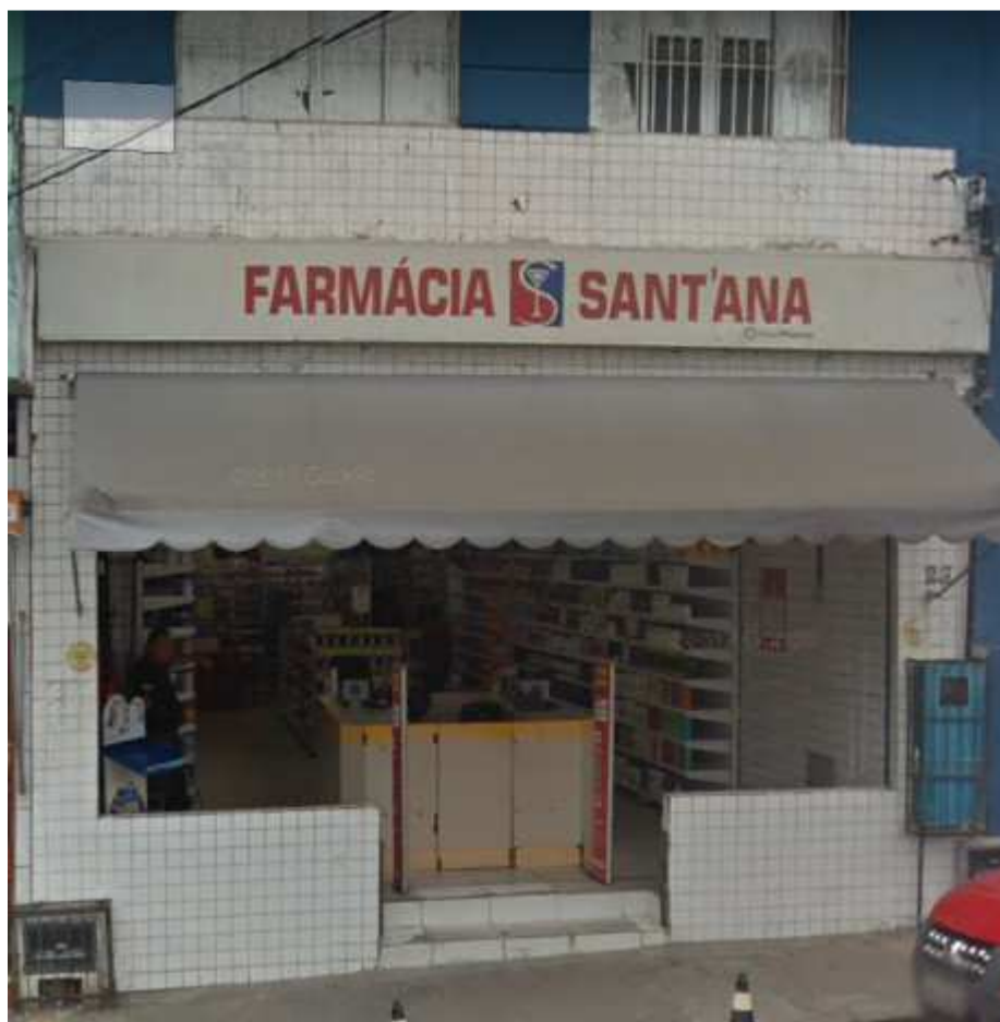
Vista do Ponto Comercial do Imóvel I, localizado na Rua do Uruguay, nº 23, Bairro Mares, Salvador, Bahia.
