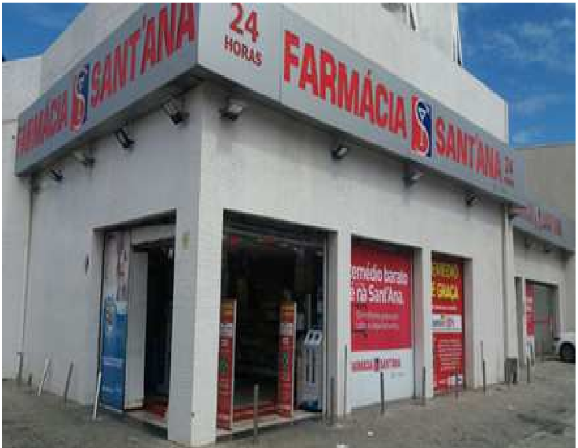
Vista do Ponto Comercial do Imóvel XLIX, localizado na Avenida Manoel Dias da Silva, nº 1974, Bairro Pituba, Salvador, Bahia.
