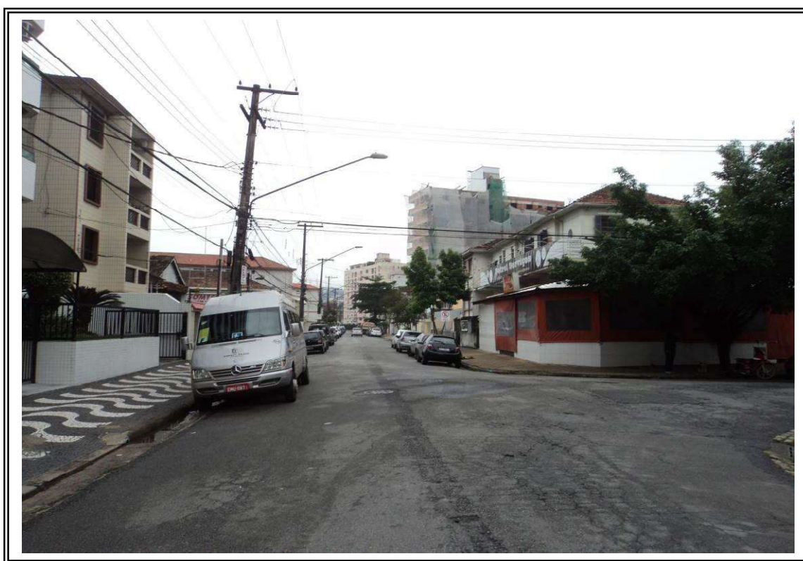
FOTO 01 – Vista da Rua Teixeira de Freitas. O observador encontra-se defronte ao Edifício Paraná olhando em direção ao centro do Município de Santos/SP.
