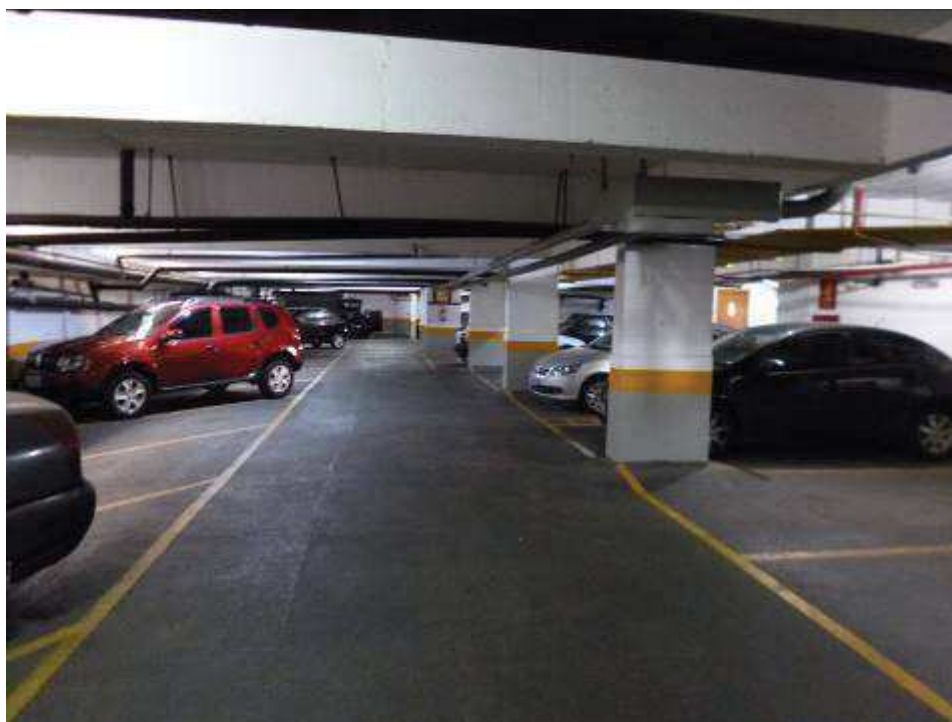
Aspectos da garagem situada no sub-solo.
