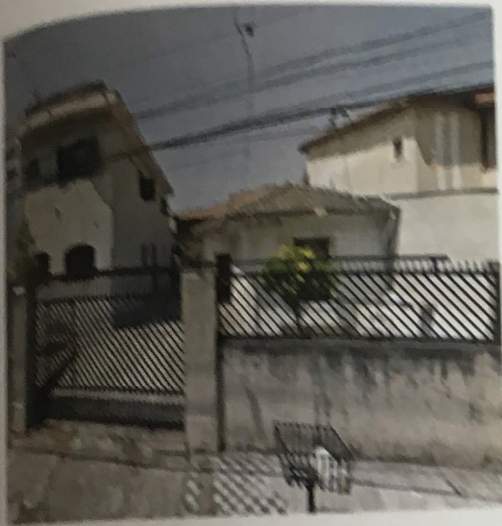
Vista da fachada frontal do imóvel
