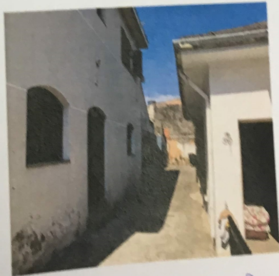
Carrador de acesso aos fundos das edificações
