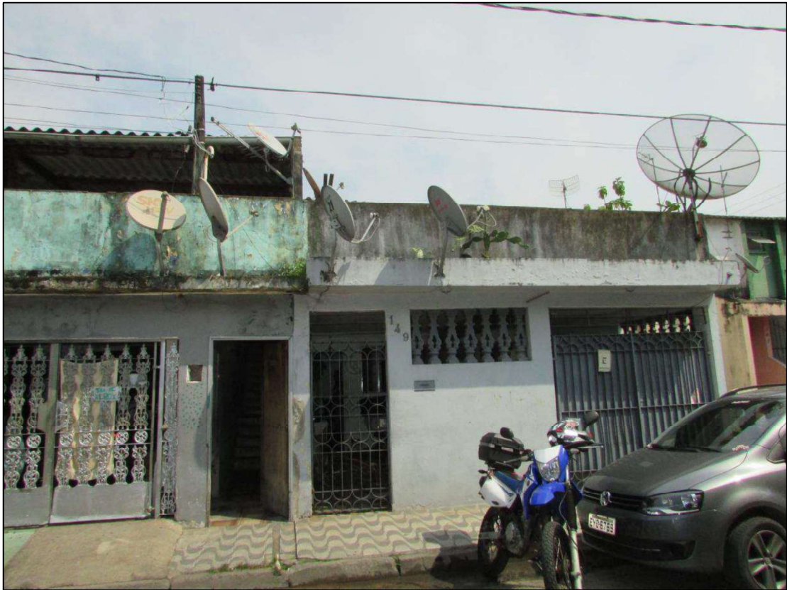
FACHADA DO IMÓVEL AVALIANDO.
