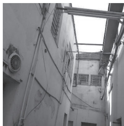
Detalhe – área administrativa
