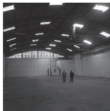
Vista interna – Prédio II
