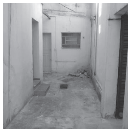
Detalhe - área administrativa
