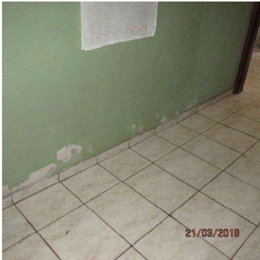
Fotos 17/18. Ilustram parede do corredor com presença de umidade.
