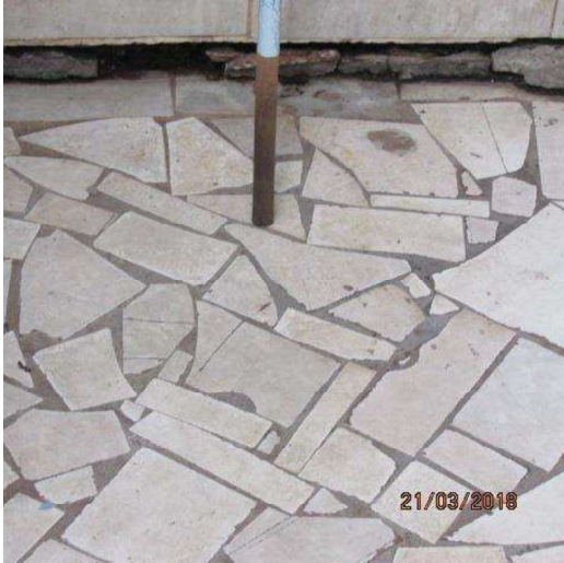
Foto 29. ilustra Piso da lavanderia.
