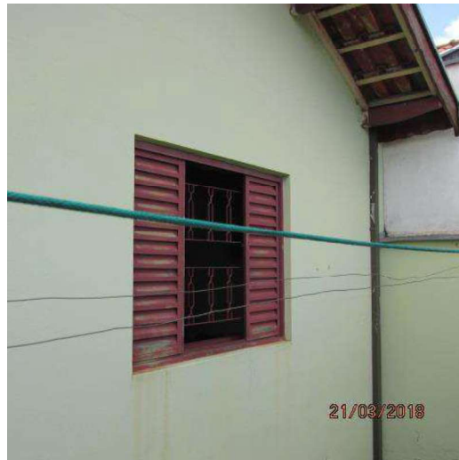
Foto 32. ilustra fachada do fundo.
