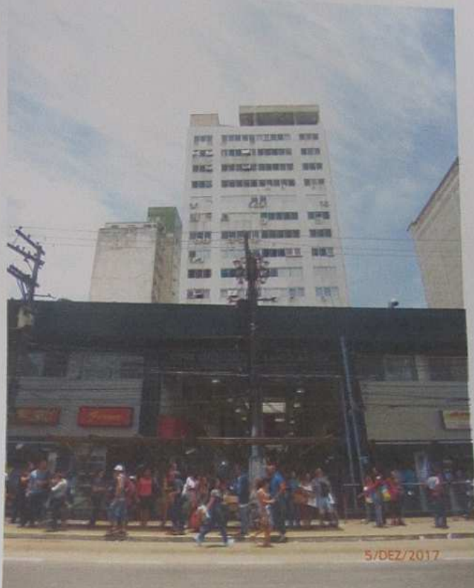
Foto nº. 02 – Vista da fachada principal do Shopping Center Santo Amaro, onde se localiza o conjunto comercial avaliado no presente trabalho.
