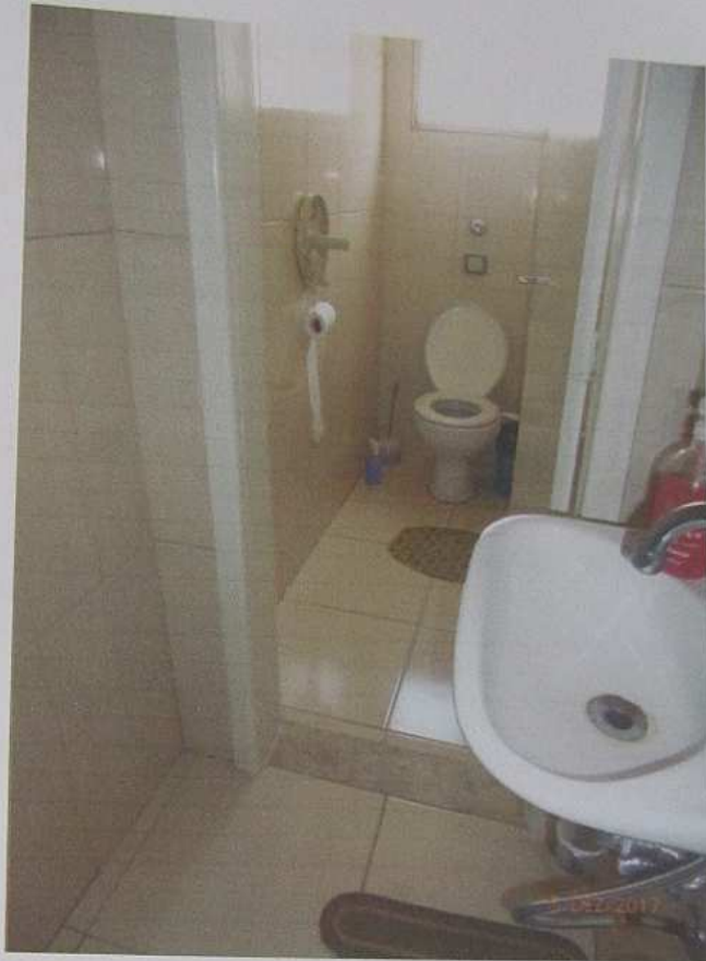
Foto nº. 16 – Vista parcial do banheiro disponível no conjunto comercial nº. 71.
