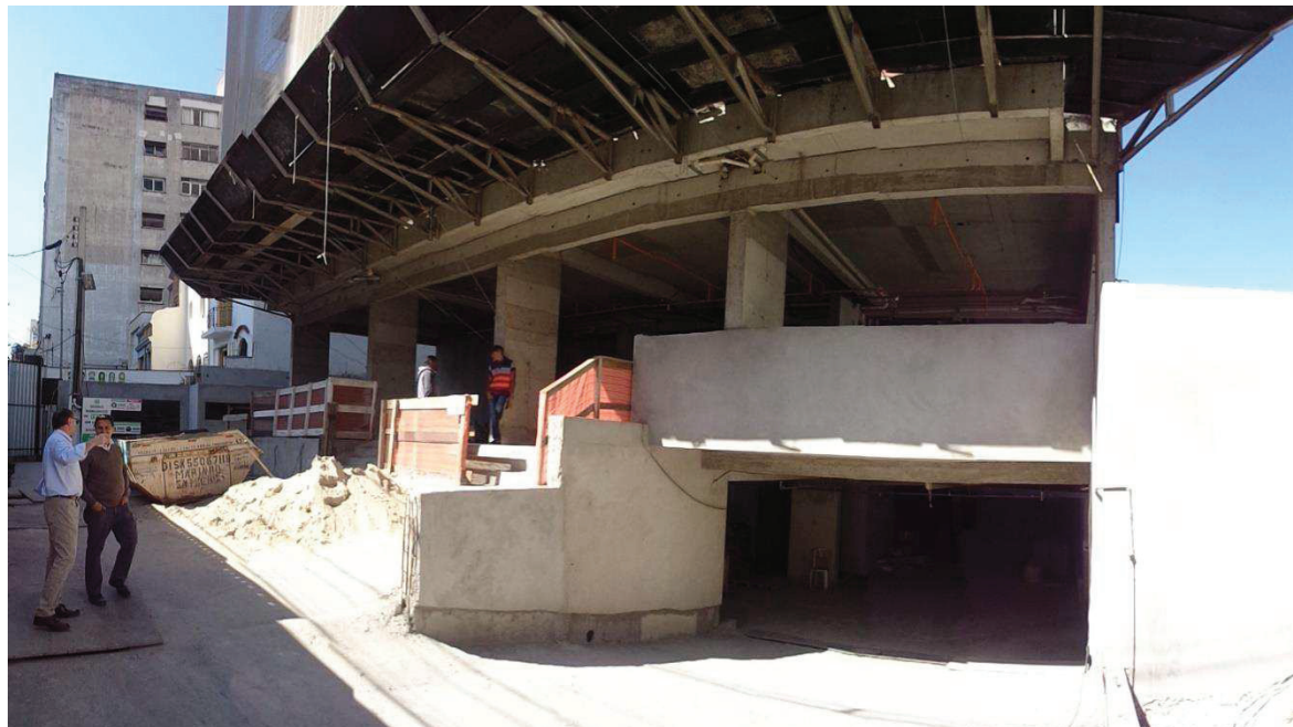
Foto 3. Obras no pav. Térreo.
