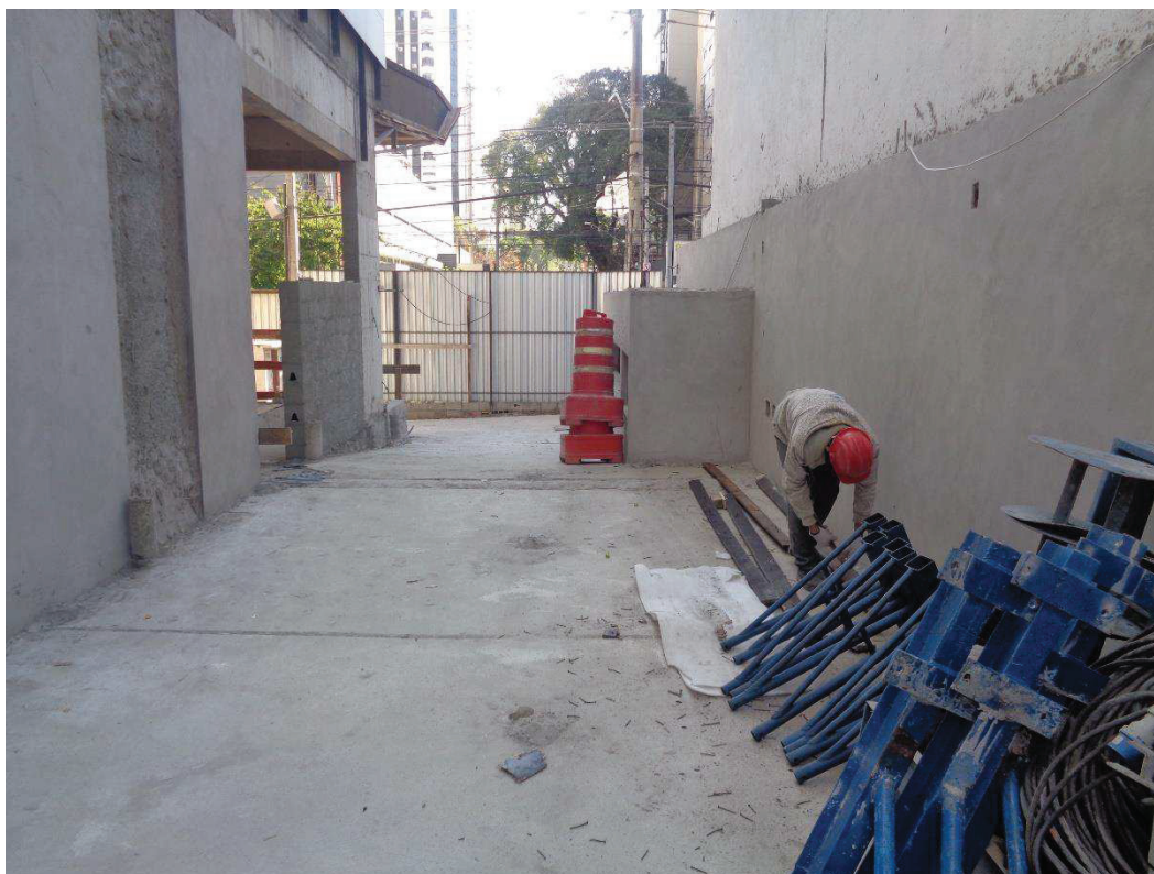
Foto 6. Corredor lateral pav. Térreo.
