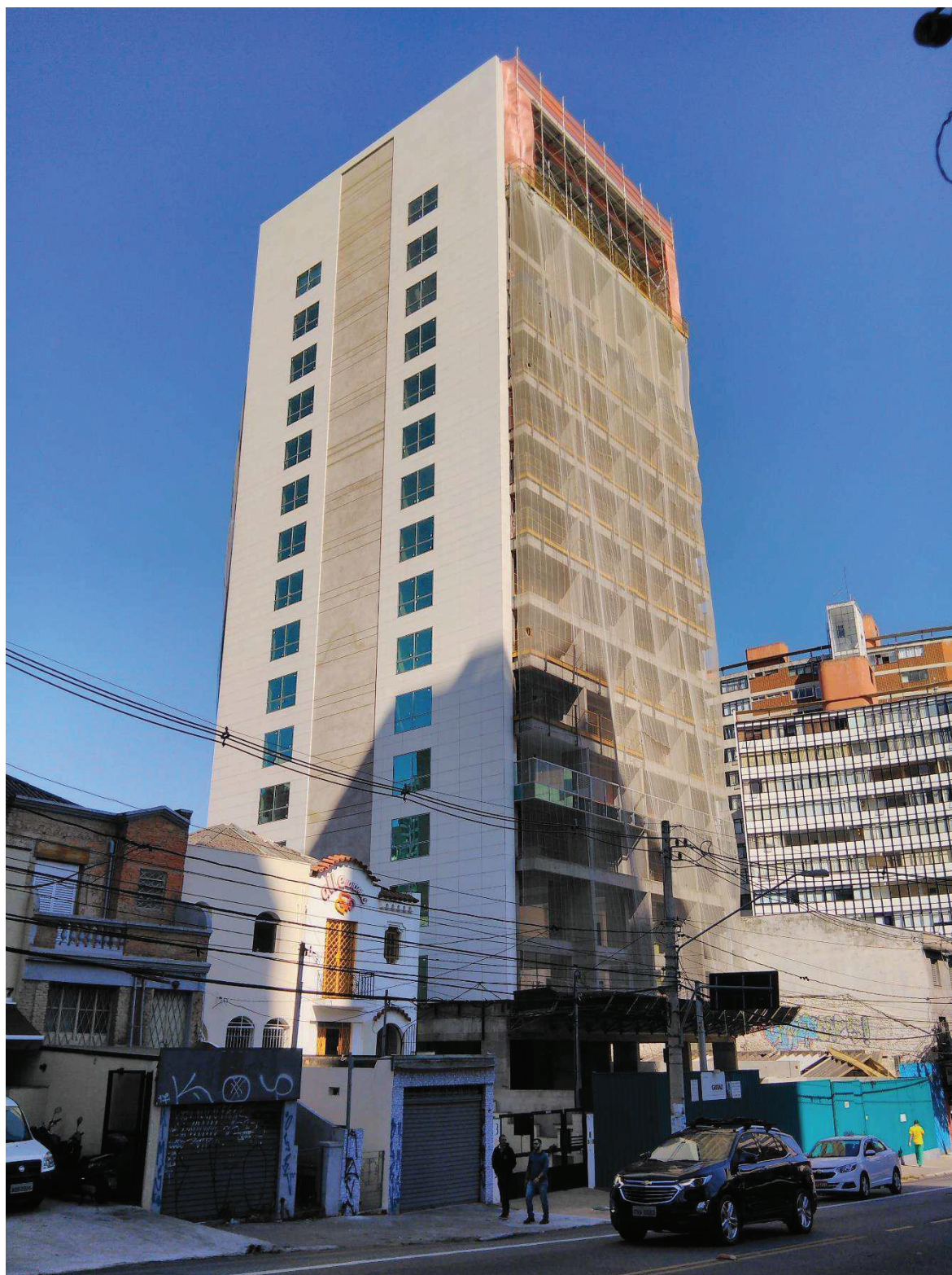
Foto 1. Edifício em construção.
