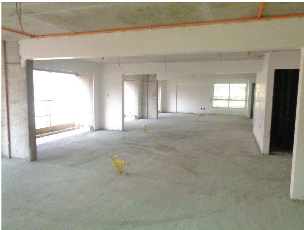
Foto 10. Salas do 7º pavimento em construção, vista do lado oposto do pavimento.
