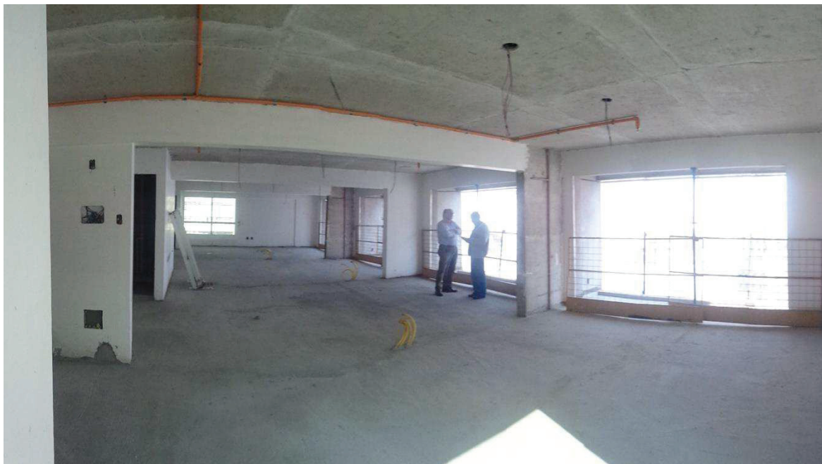
Foto 9. Salas do 7º pavimento em construção.
