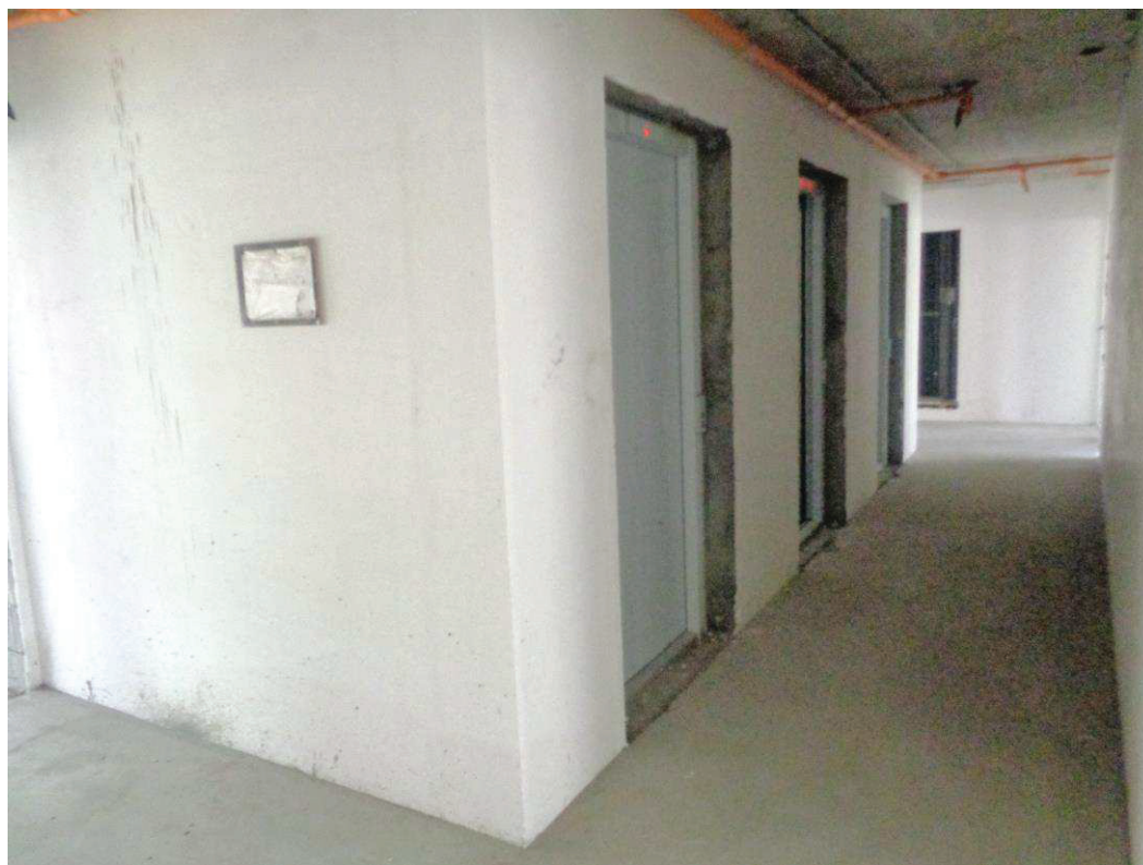
Foto 12. Hall de elevadores.
