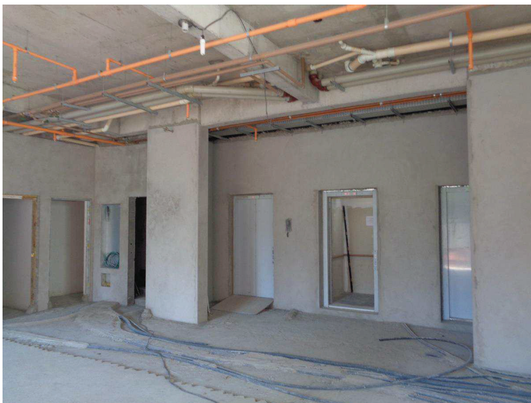
Foto 5. Recepção e elevadores.
