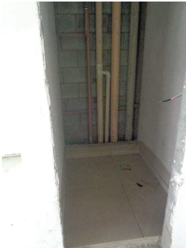
Foto 11. Detalhe do banheiro das salas.
