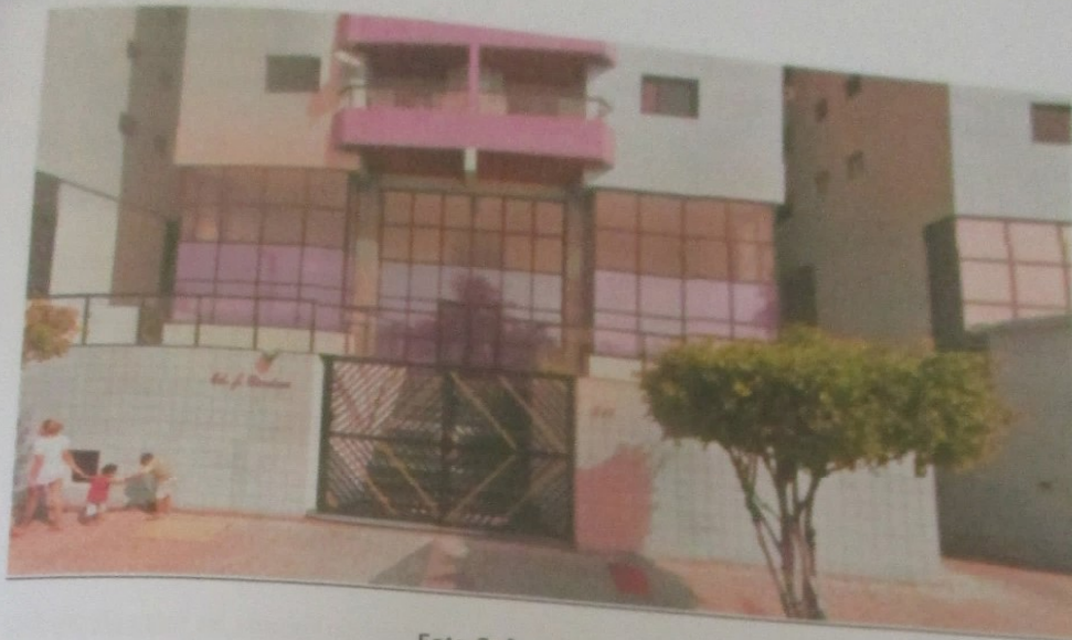
Foto 2: frente do imóvel
