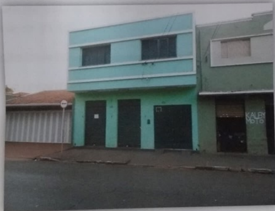
Fachada do Imóvel – Prédio residencial e comercial
