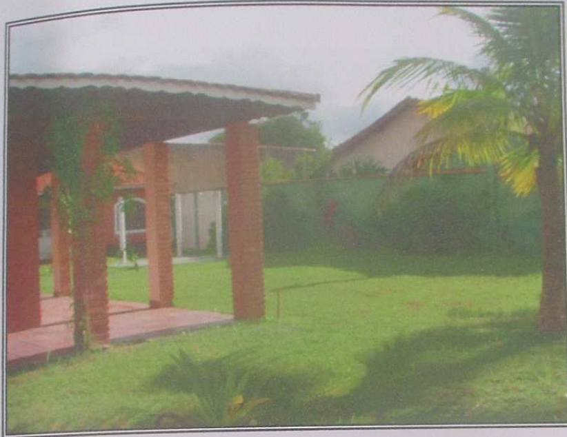
Fotografia 07 – Vista da edificação secundária mais aos fundos erigida sobre o lote 12 da quadra 14, Jardim Regina "A"; notar o bom acabamento, de padrão médio e, em primeiro plano pilares da construção principal, observada em fotografia anterior.
