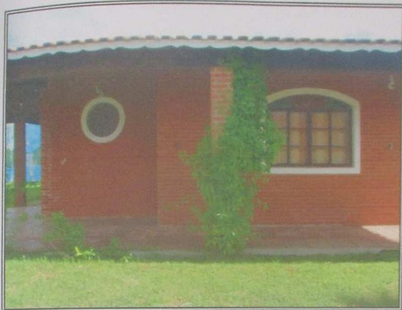
Fotografia 08 – Vista da fachada frontal da edificação principal erigida sobre o lote 11 da quadra 14, Jardim Regina "A"; notar o bom acabamento, de padrão médio.
