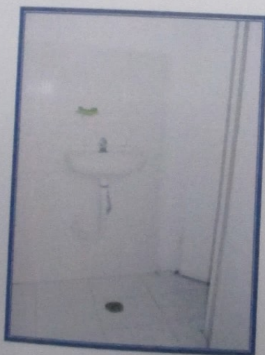
FOTO Nº 03: N° 106 – Térreo – WC.
