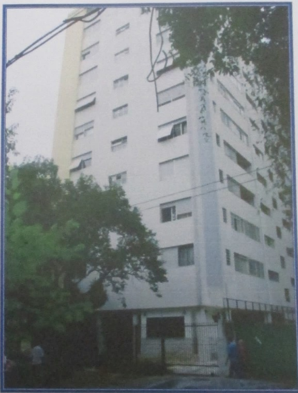
FOTO Nº 01: Vista do prédio onde se localiza o apartamento avaliando.
