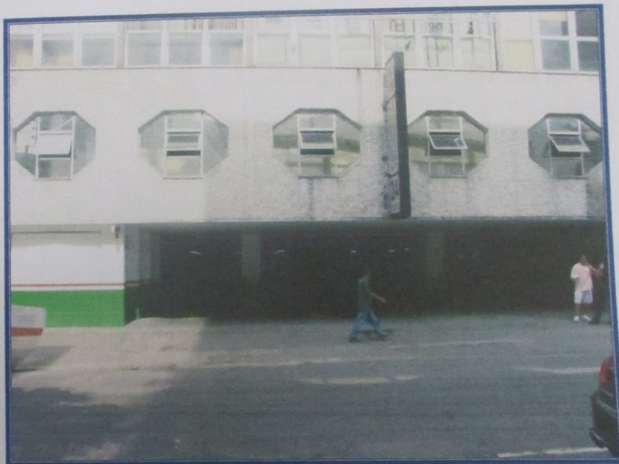
FOTO Nº 01: Vista da frente do prédio onde se localiza a garagem avalianda.
