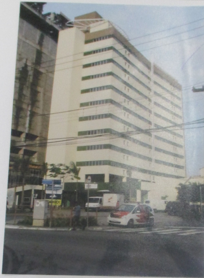
FOTO Nº06: Detalhe do prédio comercial na região com entrada pela Rua Voluntários da Pátria.
