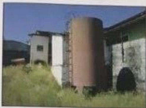
Foto 17: Fachada posterior da edificação
