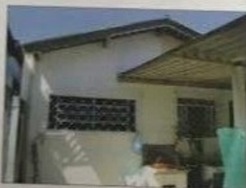
Foto 66: Detalhe da fachada posterior
