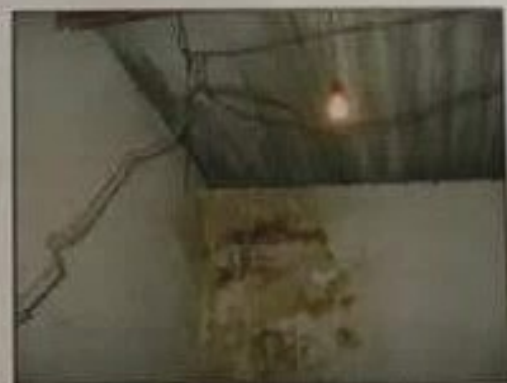
Foto 22: Interior da edificação
