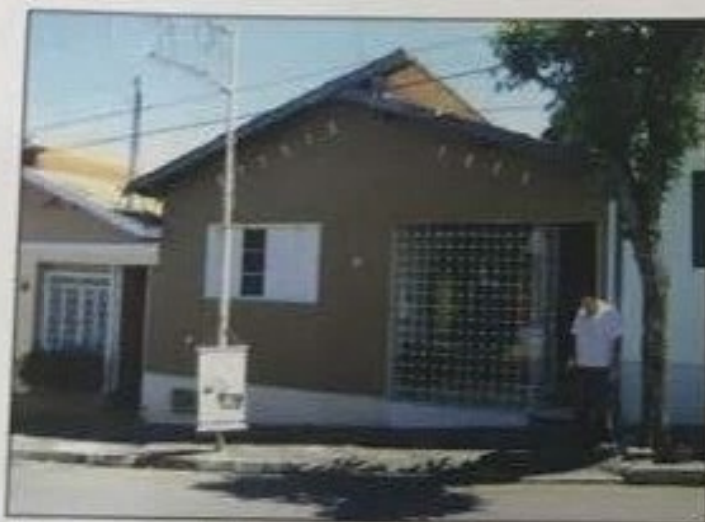
Foto 52: Vista da fachada
