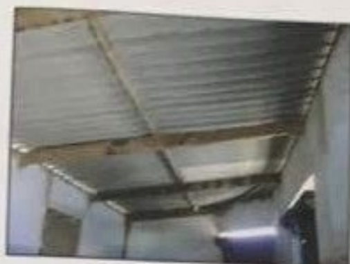
Foto 06: Cobertura do salão
