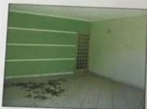
Foto 30: Abrigo para veículos
