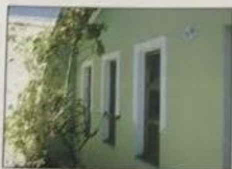
Foto 29: Detalhe da fachada
