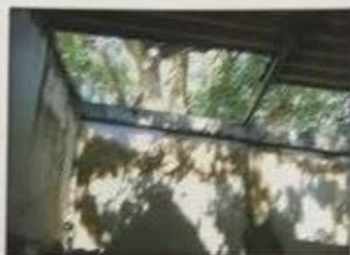
Foto 07: Cobertura do salão
