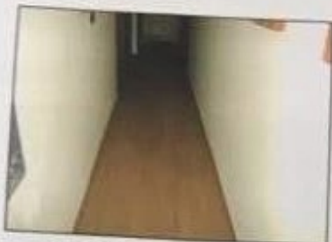
Foto 34: Corredor de circulação
