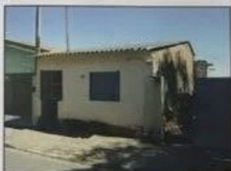
Foto 13: Fachada da edificação
