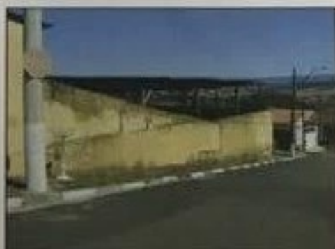
Foto 03: Fachada voltada para a Rua Santo Antonio
