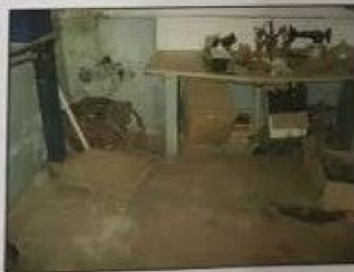
Foto 21: Interior da edificação
