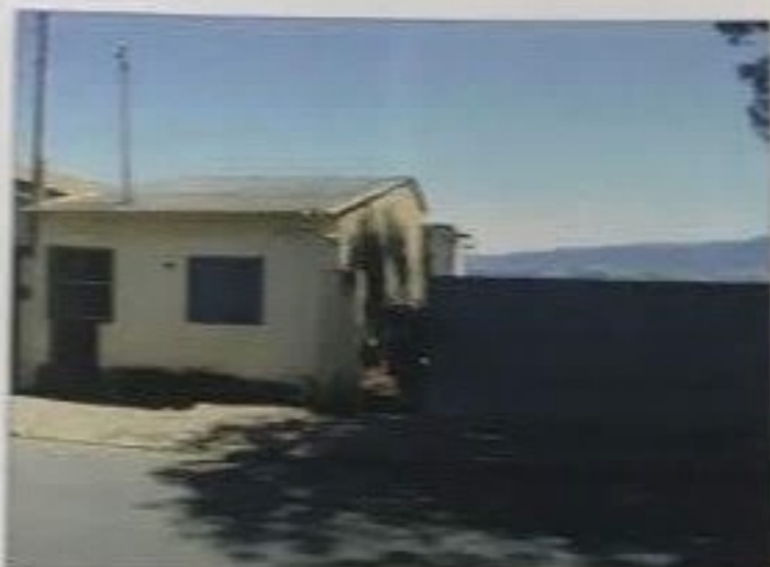
Foto 12: Vista da fachada
