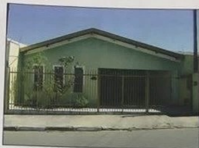
Foto 27: Vista da fachada
