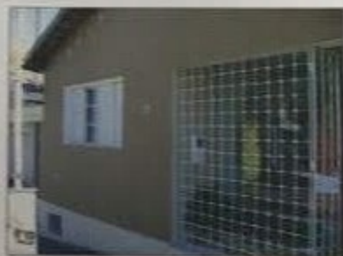
Foto 54: Detalhe da fachada
