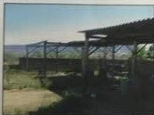
Foto 09: Cobertura em estrutura de madeira
