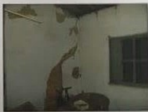
Foto 20: Interior da edificação
