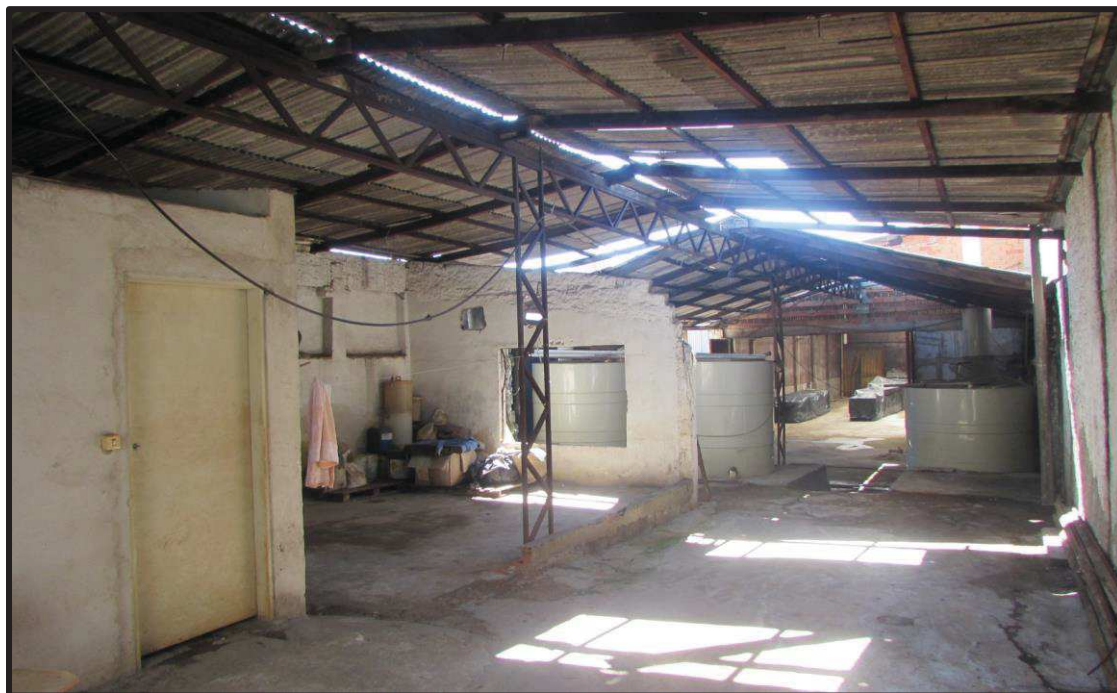
Vista do galpão I
