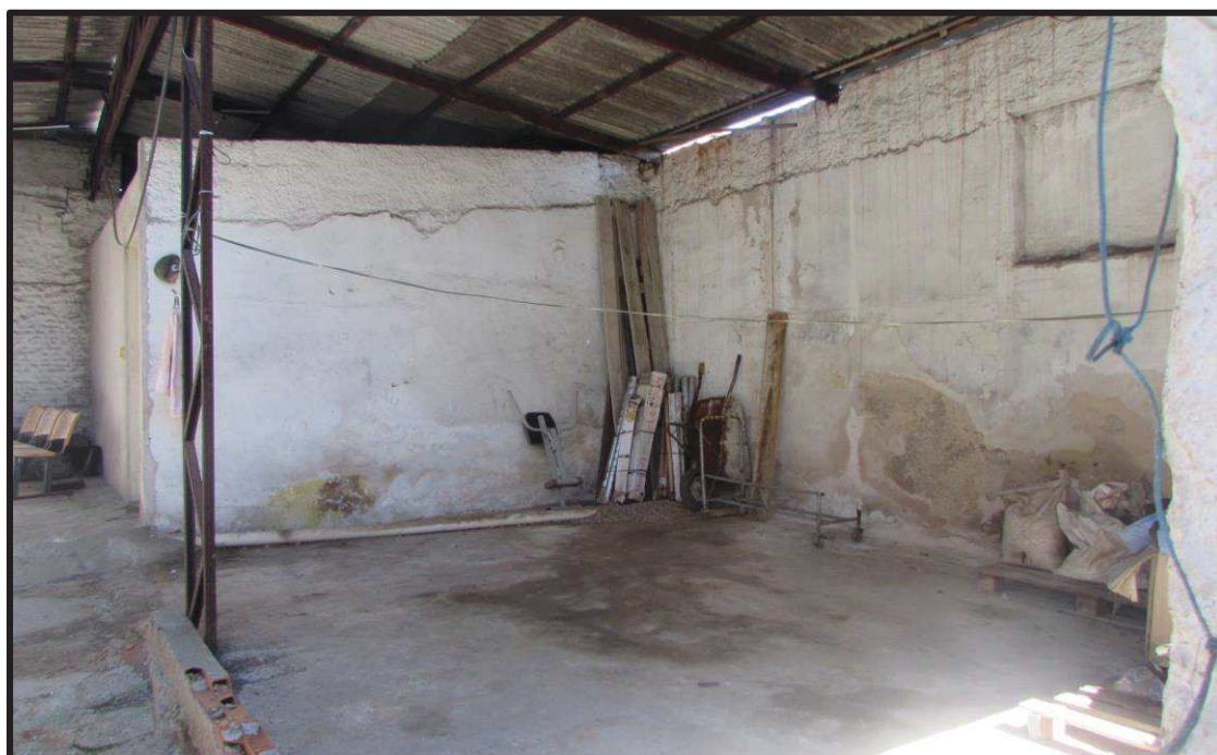
Vista do galpão I
