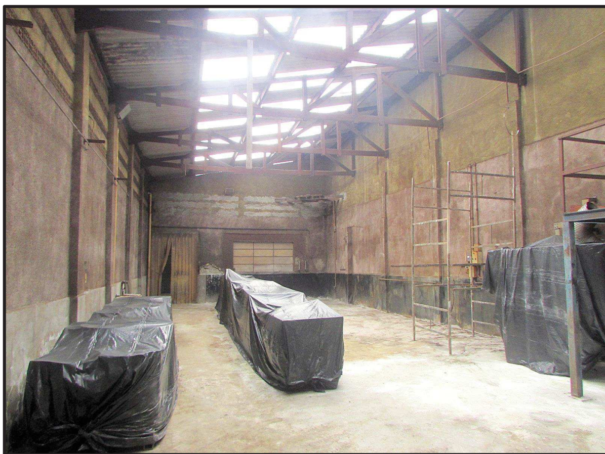
Vista do galpão II
