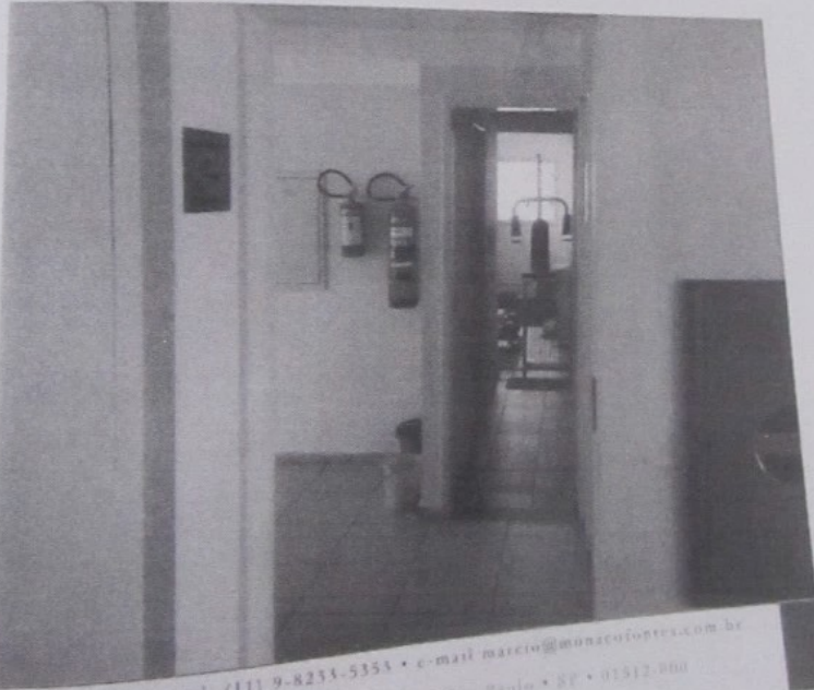
Acima e abaixo, tem-se a tomada do hall de entrada do Edifício em questão, onde nota-se piso em cerâmica, paredes e teto revestidos com massa fina pintada e guarda corpo de ferro e vidro.
