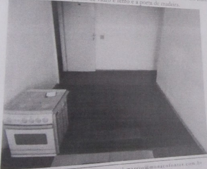
Acima, bem como abaixo, é possível observar as paredes e o teto revestidos em massa fina pintadas, o piso em madeira, a janela de vidro e ferro e a porta de madeira.
