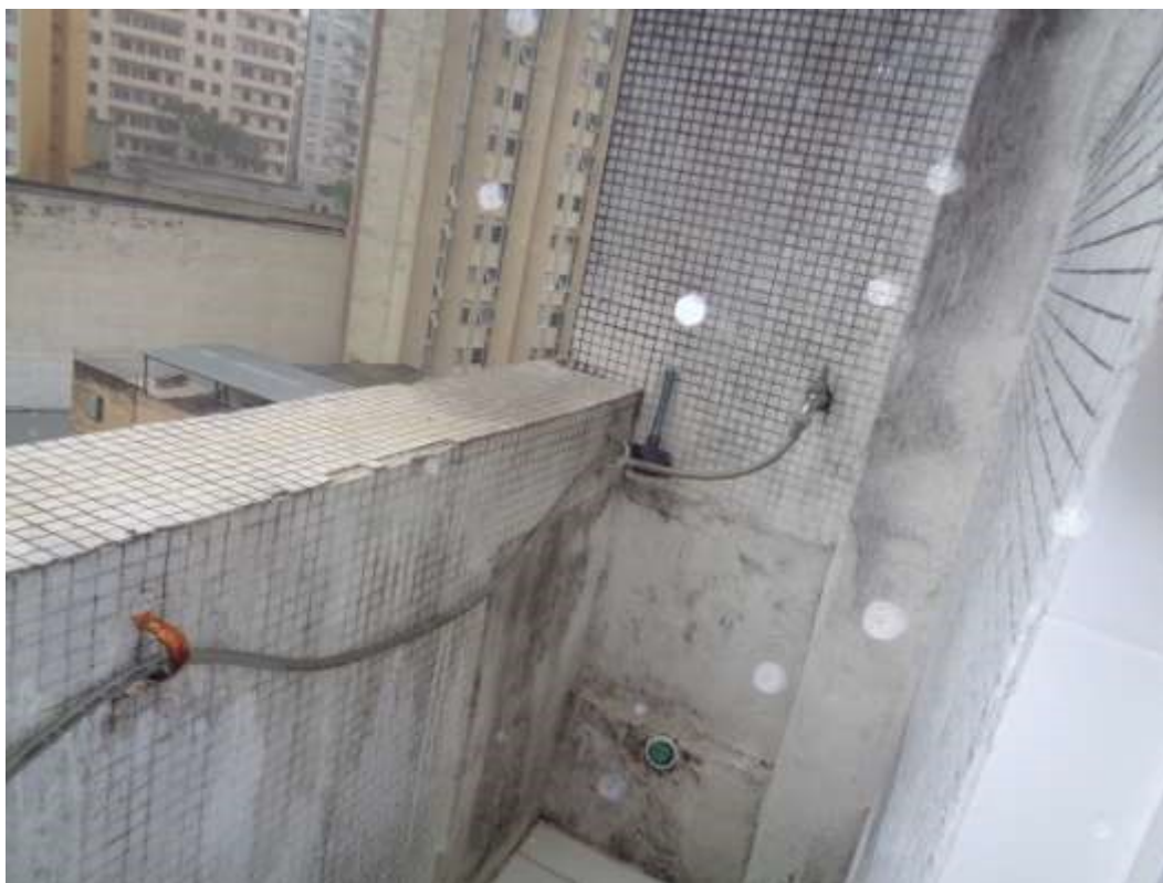
Foto 11, Área de serviço, vista de outro ângulo.
