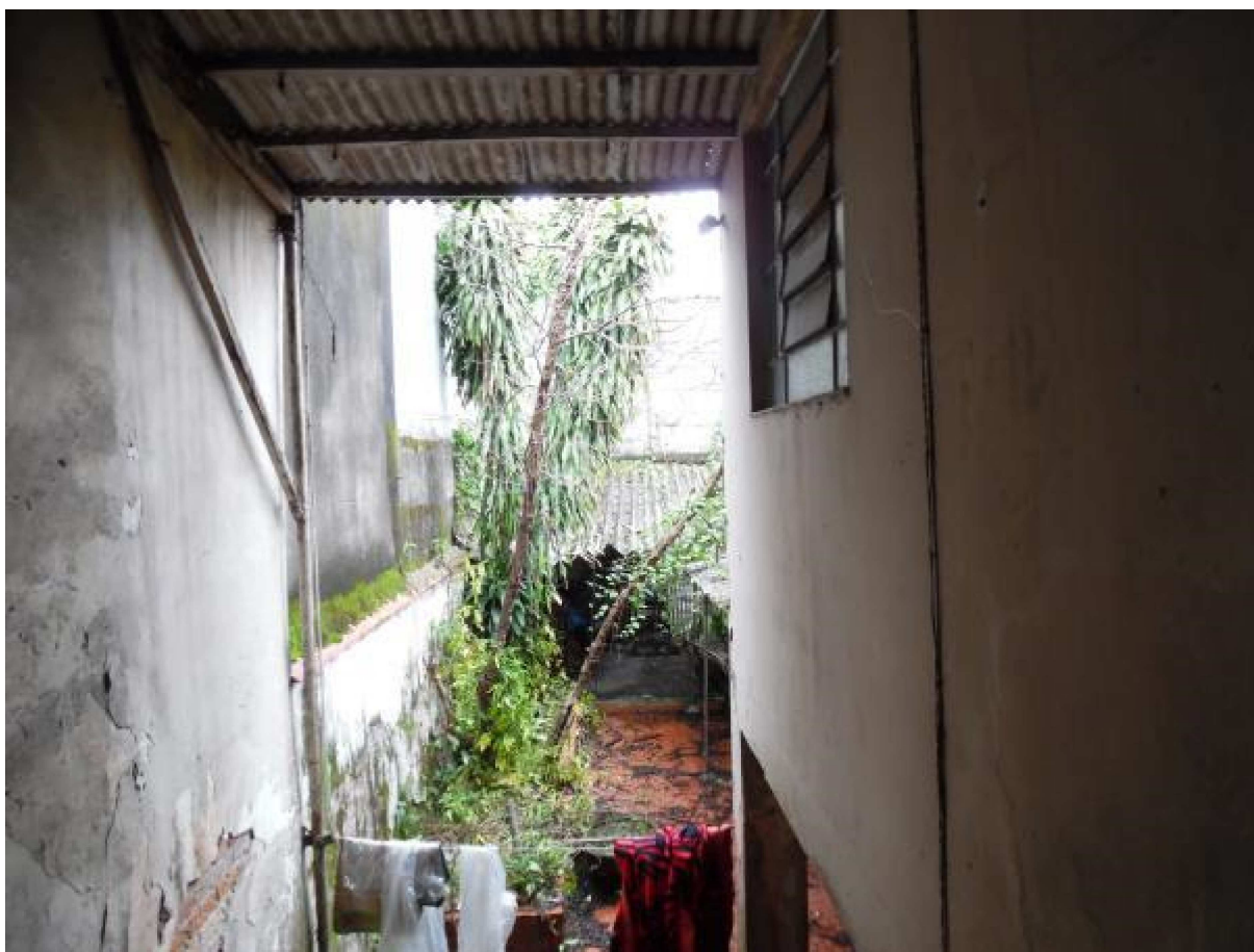
FOTO 08:- Vista do quintal do imóvel.
