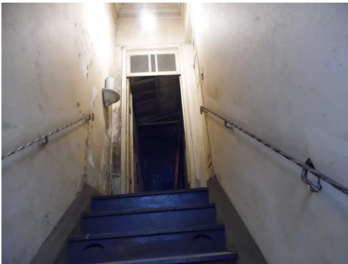
FOTO 04:- Vista da escada de acesso ao pavimento superior do imóvel.
