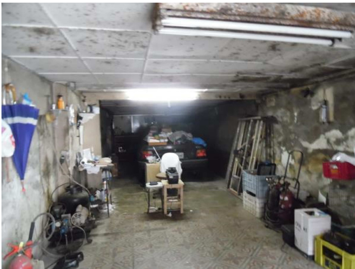
FOTO 03:- Vista da garagem do imóvel.
