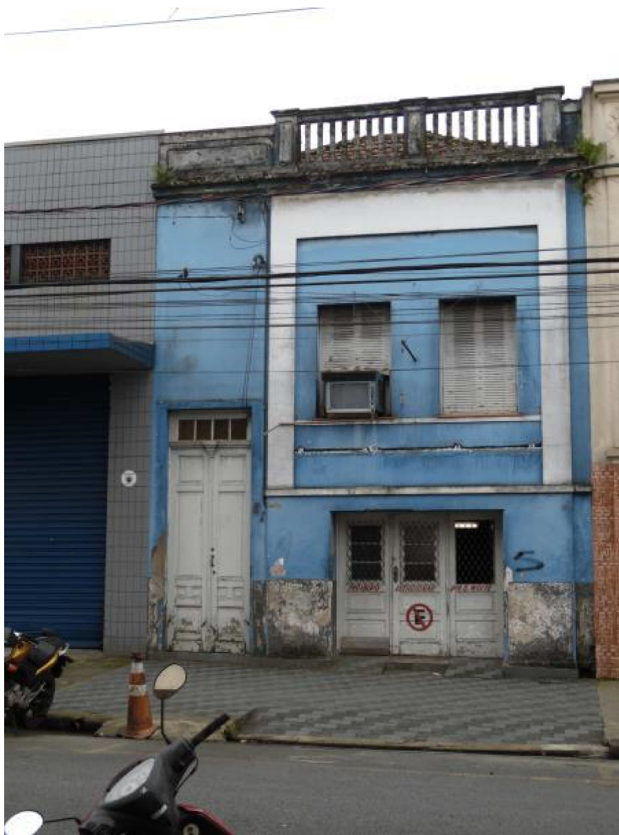
FOTO 02:- Vista do imóvel.
