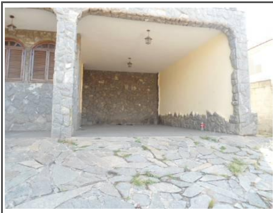
FOTO 4 - VISTA DA GARAGEM
