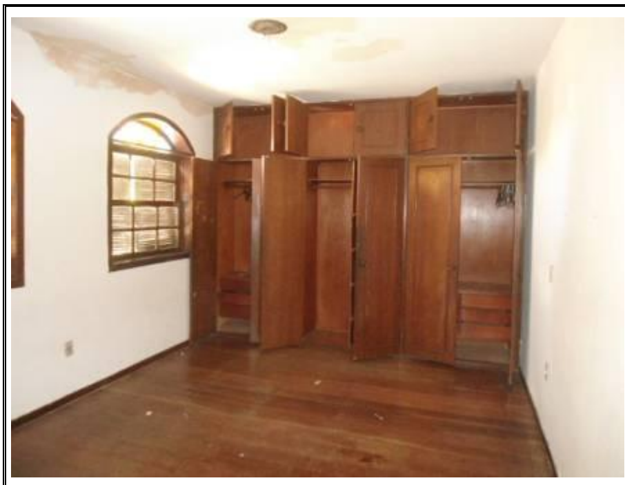
FOTO 12 - VISTA DO QUARTO PAV. SUPERIOR
