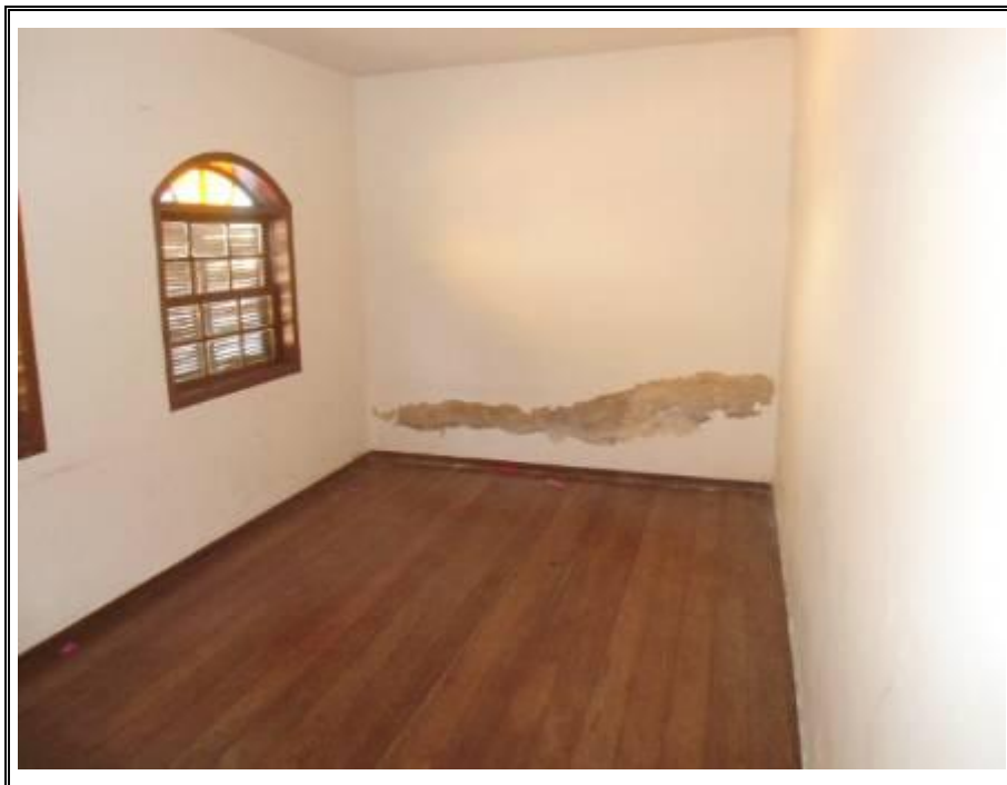
FOTO 6 - VISTA DA SALA
