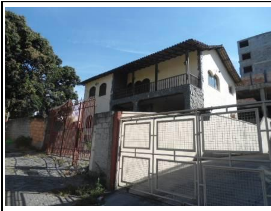
FOTO 1 - VISTA DA FACHADA
