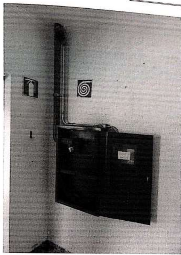
VISTA DA SALA DO FIM...
