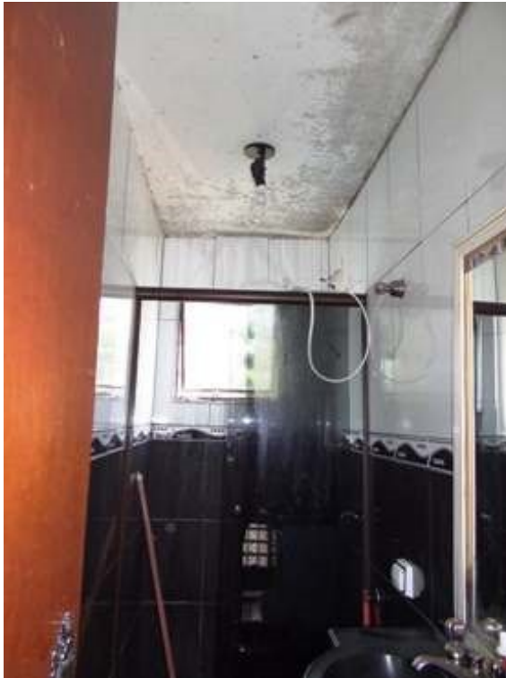
Foto 19: Piso Superior - Vista WC
