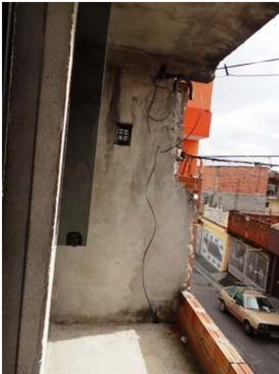
Foto 30: Piso Superior - Vista Varanda
