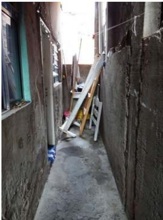
Foto 40: Piso Inferior - Vista Corredor
