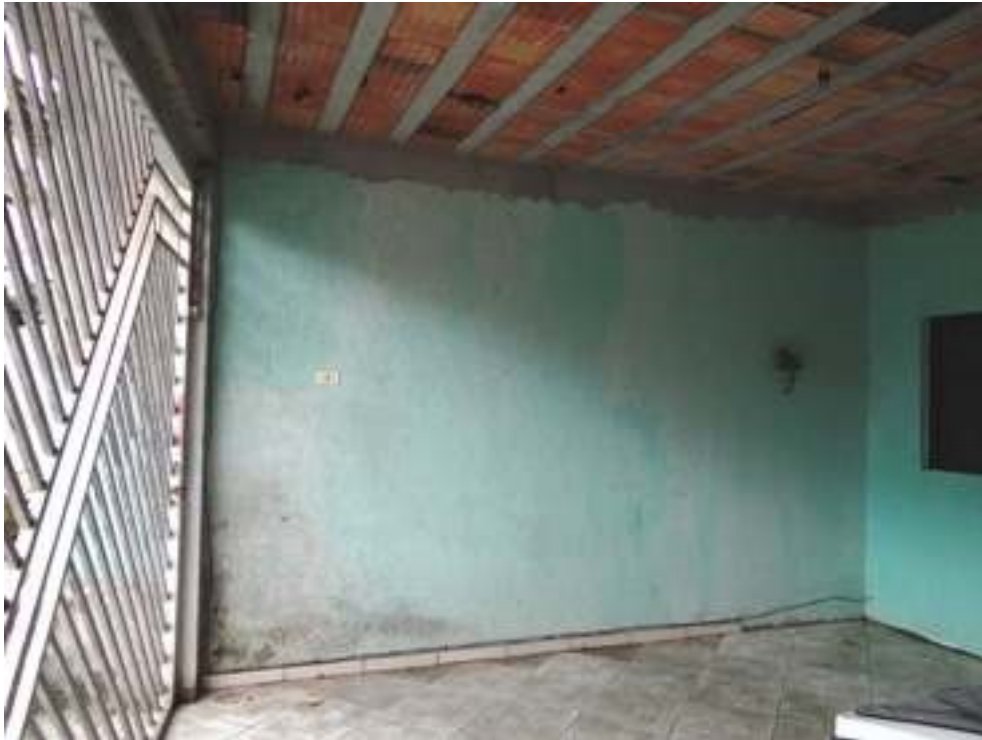
Foto 5: Piso térreo - Vista Garagem
