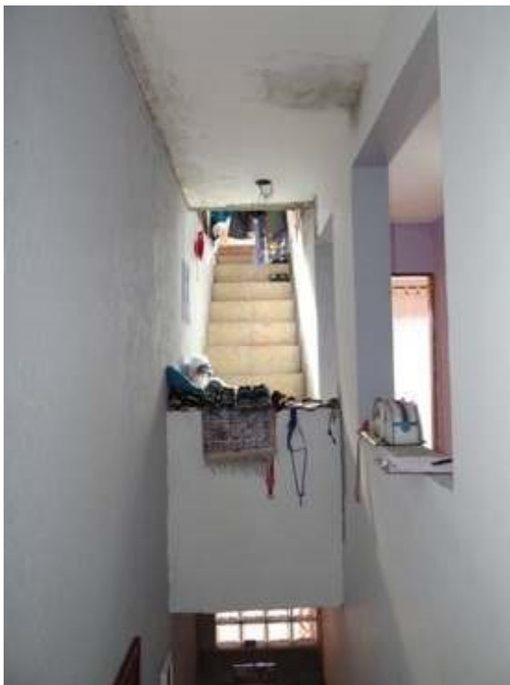
Foto 32: Piso Superior - Vista Escada Laje
