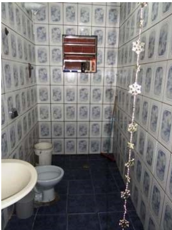
Foto 48: Vista WC Casa Inferior
