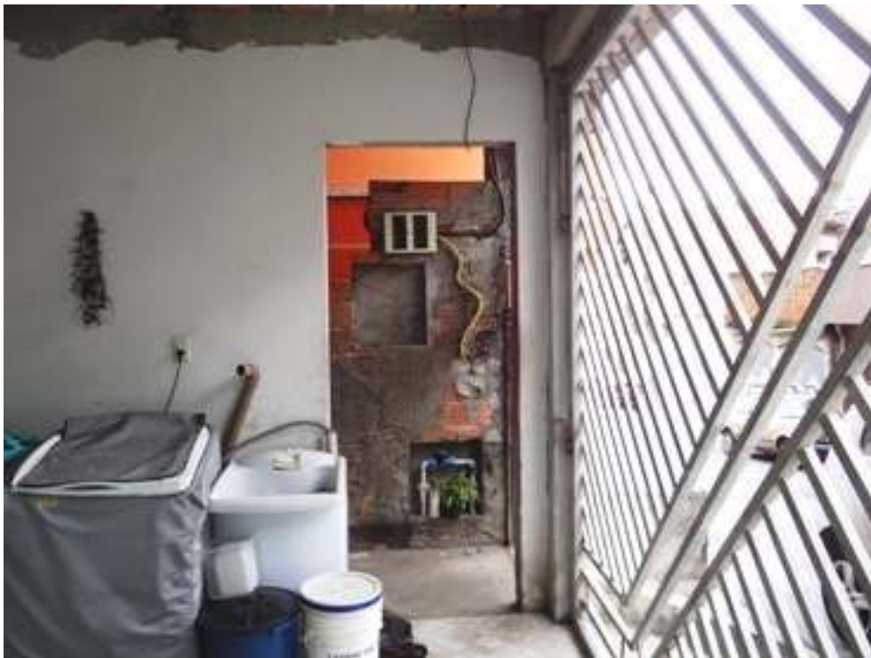
Foto 6: Piso térreo - Vista Garagem
