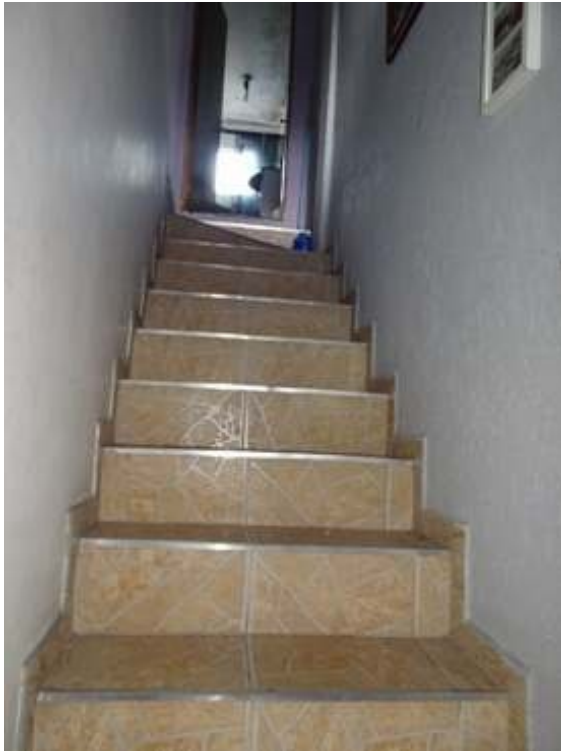
Foto 17: Vista Escada de acesso ao Piso Superior
