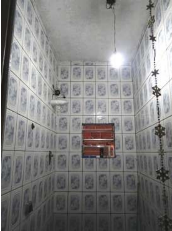
Foto 47: Vista WC Casa Inferior
