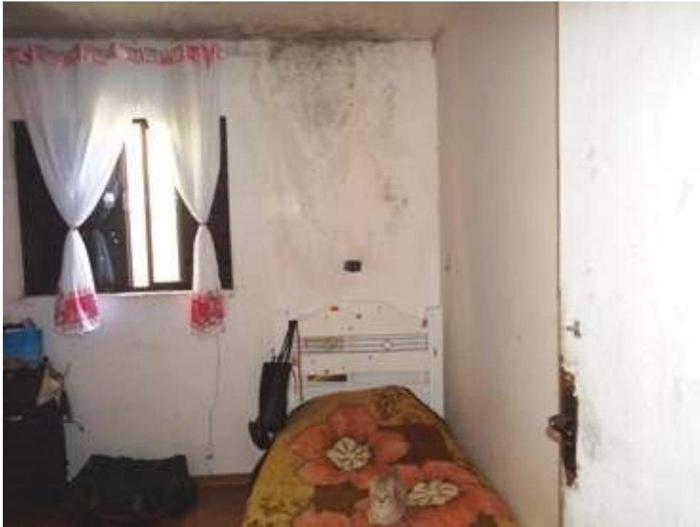
Foto 23: Piso Superior - Vista Dormitório I
