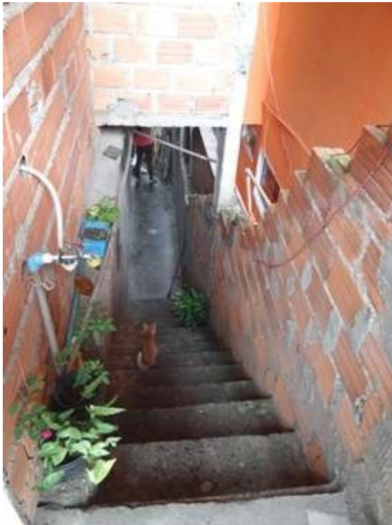
Foto 39: Vista Escada de acesso ao piso inferior.
