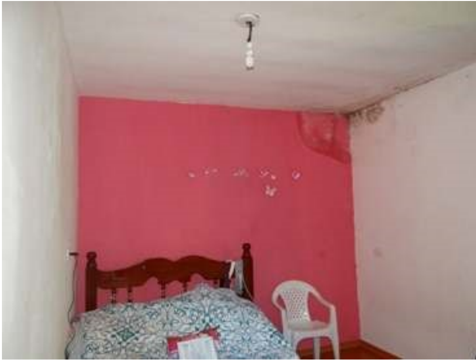
Foto 21: Piso Superior - Vista Dormitório I
