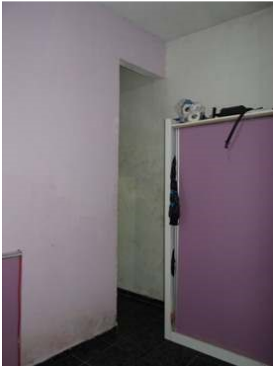
Foto 45: Vista Sala/Quarto Casa Inferior
