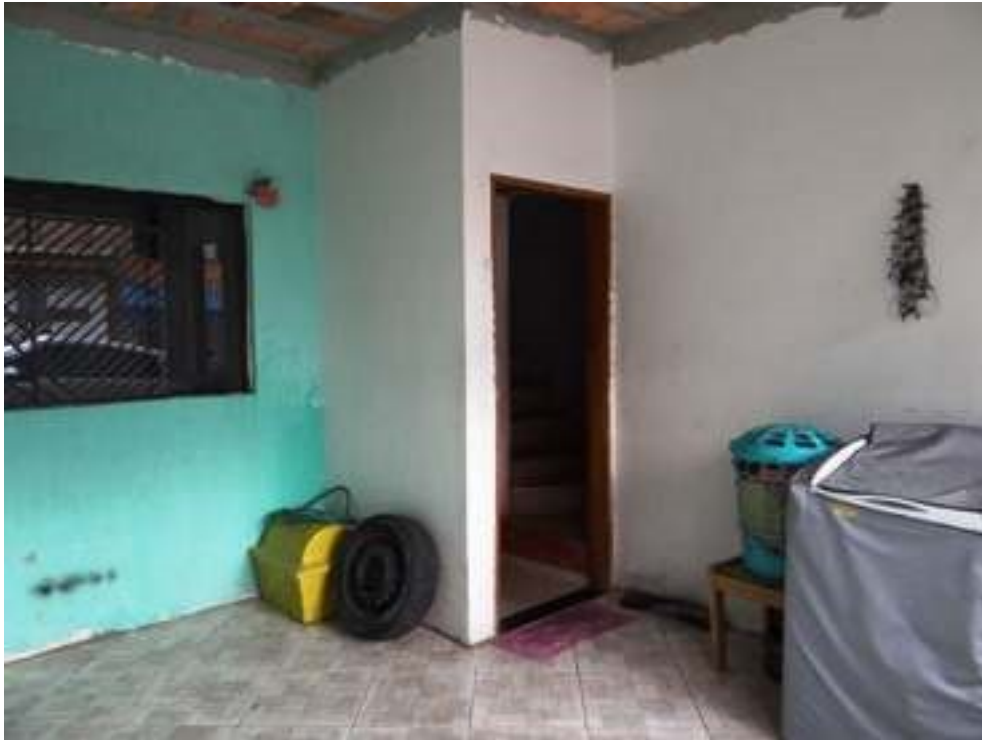
Foto 7: Piso térreo - Vista Garagem
