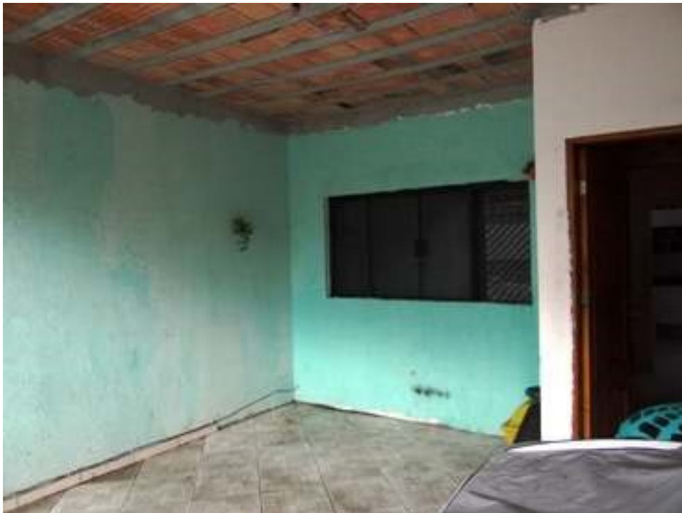
Foto 4: Piso térreo - Vista Garagem
