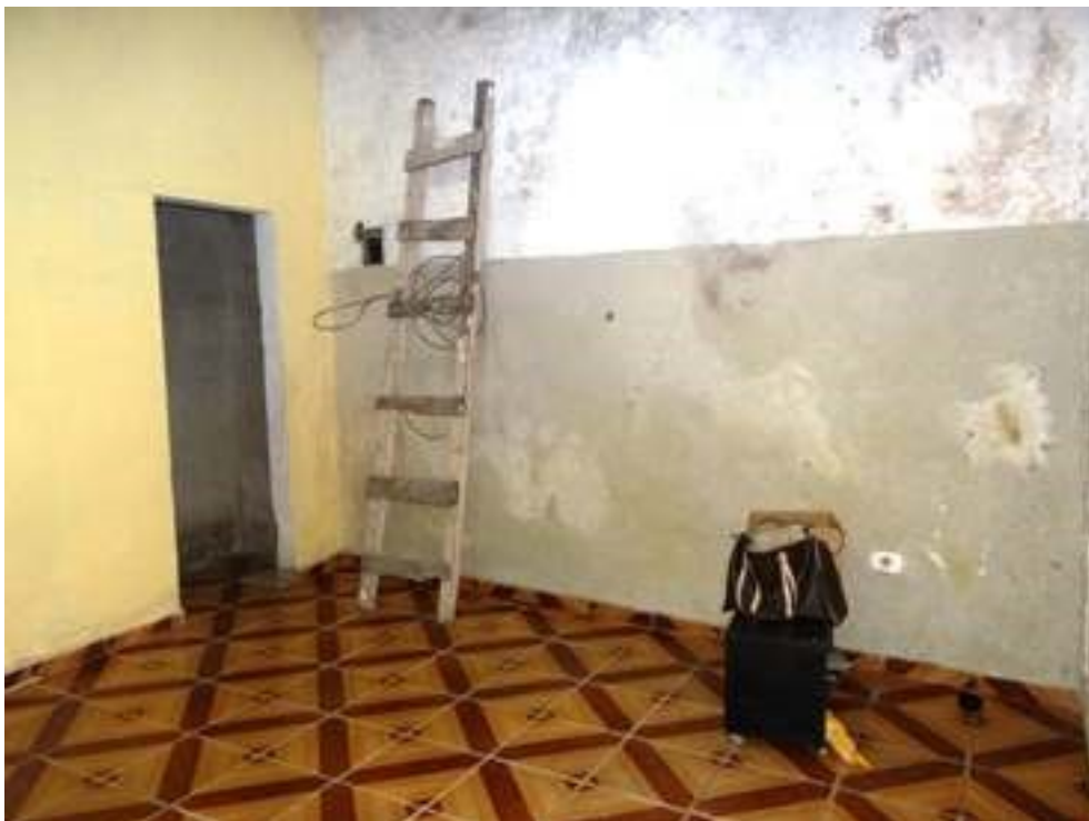
Foto 50: Vista Dormitório Casa Inferior
