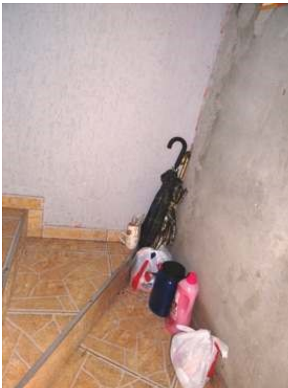
Foto 16: Vista Escada de acesso ao Piso Superior
