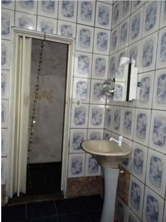
Foto 49: Vista WC Casa Inferior
