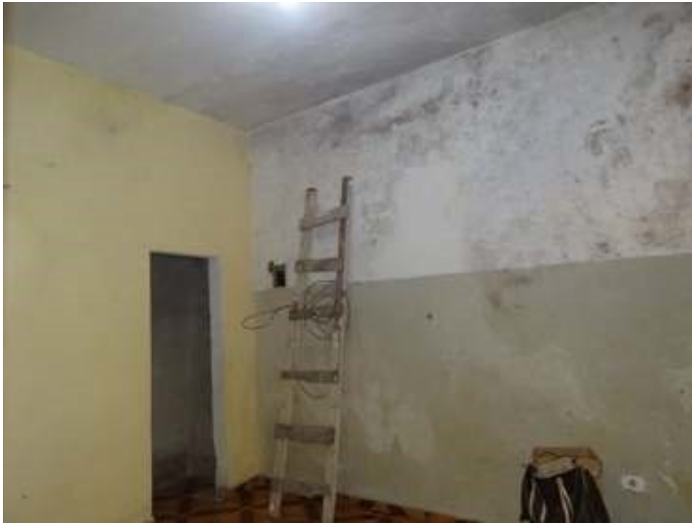
Foto 51: Vista Dormitório Casa Inferior
