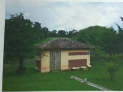
FOTO Nº 60 – Vista parcial externa do paiol. Nota-se as características físicas da construção.
