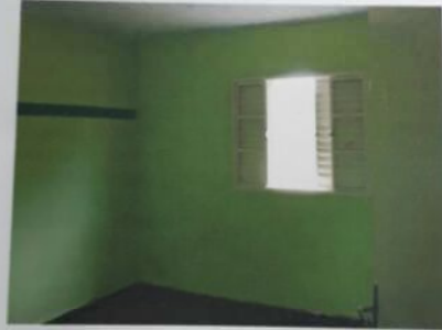
FOTO Nº 58 - Vista parcial interna do dormitório da casa do caseiro. Nota-se as características físicas da construção.
