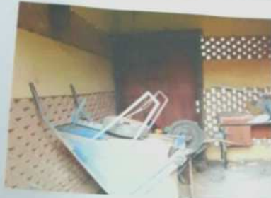
FOTO Nº 61 – Vista parcial interna do paiol. Nota-se as características físicas da construção.
