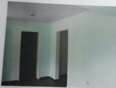
FOTO Nº 82 - Vista parcial da sala com acesso a cozinha e demais cômodos casa de caso. Nota-se as características das condições físicas e de construção.
