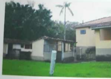
FOTO Nº 59 – Vista parcial externa da garagem, chiqueiro e casa do caseiro. Nota-se as características físicas da construção.
