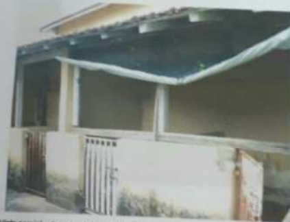
FOTO Nº 58 - Vista parcial externa do chiqueiro. Nota-se as características físicas da construção.
