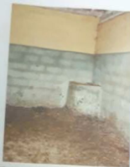
FOTO Nº 41 - Vista parcial interna da sala. Nota-se as características físicas da construção.
