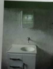
FOTO Nº 66 – Outra vista parcial interna do banheiro da casa do caseiro. Nota-se as características físicas da construção.
