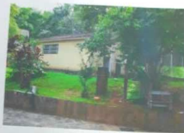
FOTO Nº 83 - Vista externa do depósito/casal. Nota-se as características das condições físicas e de construção.
