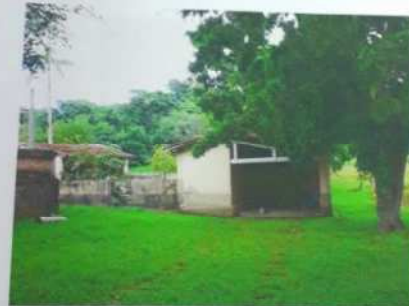
FOTO Nº 24 – Vista parcial externa da garagem, WC e depósito. Nota-se as características físicas de construção.
