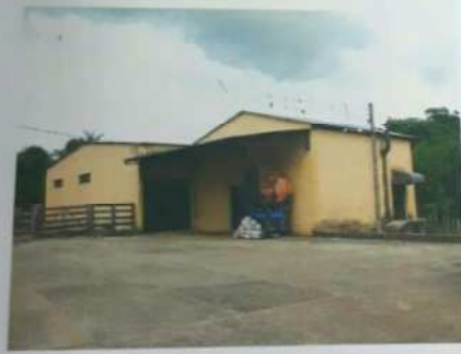
FOTO Nº 48 – Vista parcial externa da tinha. Nota-se as características físicas da construção.
