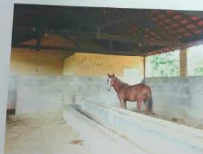
FOTO Nº 46 – Outra vista parcial interna da cocheira. Nota-se as características físicas de construção.
