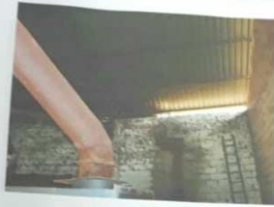
FOTO Nº 21 – Outra vista parcial interna de silo. Nota-se as características físicas de construção.
