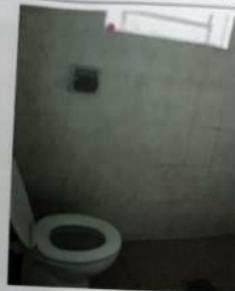
FOTO Nº 65 – Vista parcial interna do banheiro da casa do caseiro. Nota-se as características físicas da construção.
