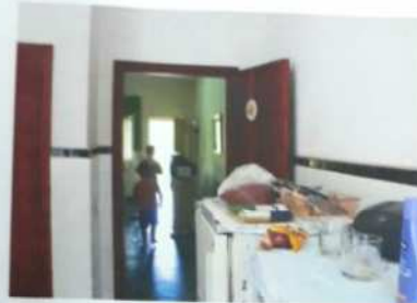
FOTO Nº 29 – Vista parcial cozinha da casa sede com acesso à sala e demais cômodos. Nota-se as características físicas da construção.
