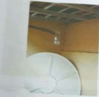
FOTO Nº 57 - Vista parcial interna do depósito. Nota-se as características físicas da construção.
