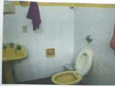
FOTO Nº 27 – Idem legenda anterior. Nota-se as características físicas da construção.
