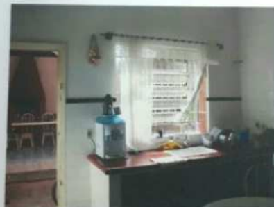
FOTO Nº 30 – Outra vista parcial cozinha da casa sede. Nota-se as características físicas da construção.
