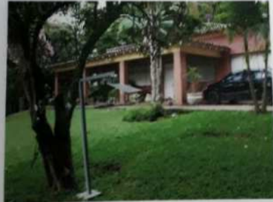
FOTO Nº 16 – Vista parcial da casa sede. Nota-se as características físicas da construção.
