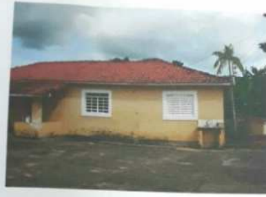
FOTO Nº 63 – Vista parcial externa da casa do caseiro e loteiro. Nota-se as características físicas da construção.
