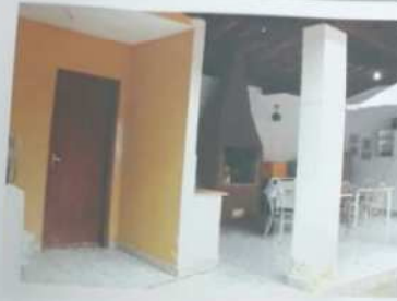
FOTO Nº 35 – Vista parcial da lavanderia, banheiro e área de lazer. Nota-se as características físicas da construção.
