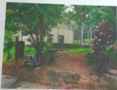
FOTO Nº 84 - Vista externa do depósito/casal. Nota-se as características das condições físicas e de construção.
