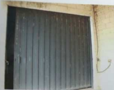
FOTO Nº 50 – Vista parcial externa da tinha e um dos portões de acesso. Nota-se as características físicas da construção.
