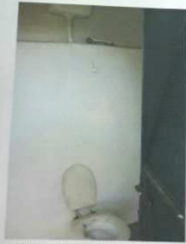
FOTO Nº 56 - Vista parcial interna do WC. Nota-se as características físicas da construção.
