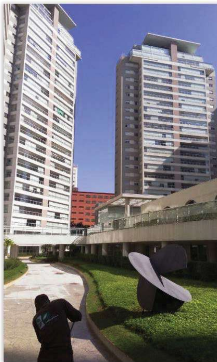
Foto 21 - Vista da área de acesso aos blocos do Condomínio.
