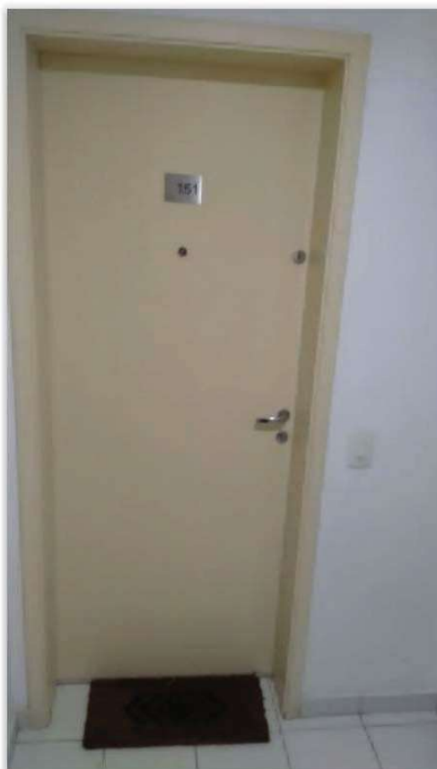
Foto 29 - Vista da porta de acesso ao imóvel vistoriando.
