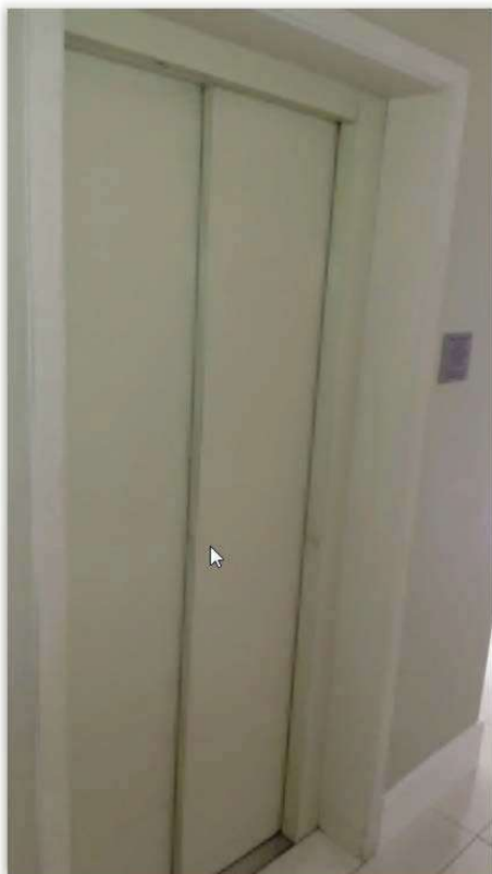
Foto 27 - Vista do elevador de serviço na área comum do Condomínio.
