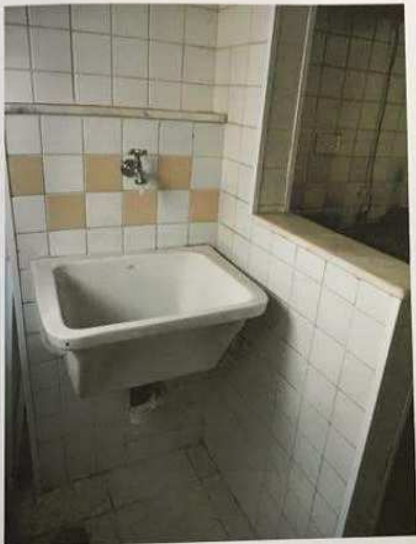
FOTO N. 13 : Área de serviço.
