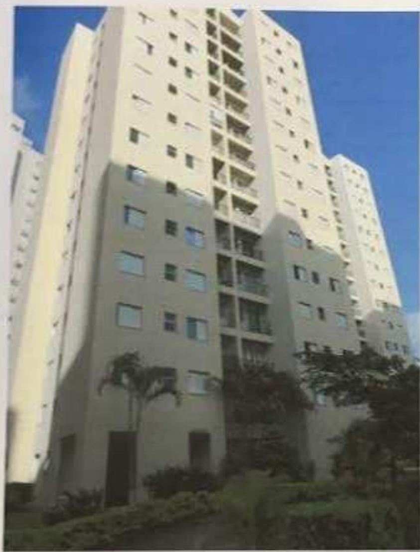
FOTO N. 06: Edifício Vivaldi ou Bloco 3.
