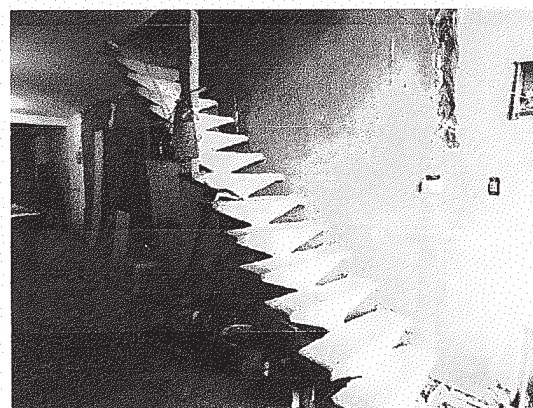
Foto 6: Vista da escada de acesso – pavimento superior
