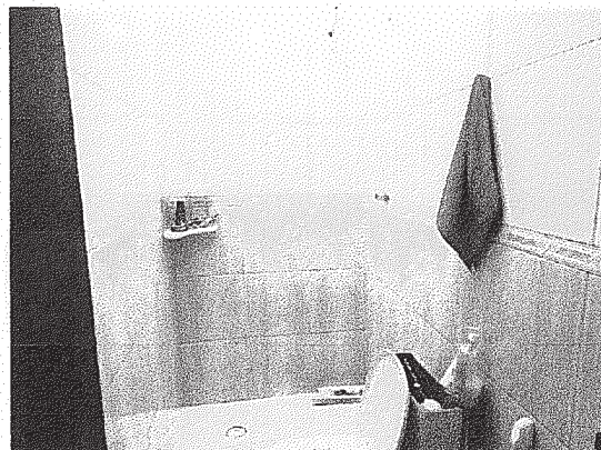
Foto 20: Vista banheiro – pav. superior
