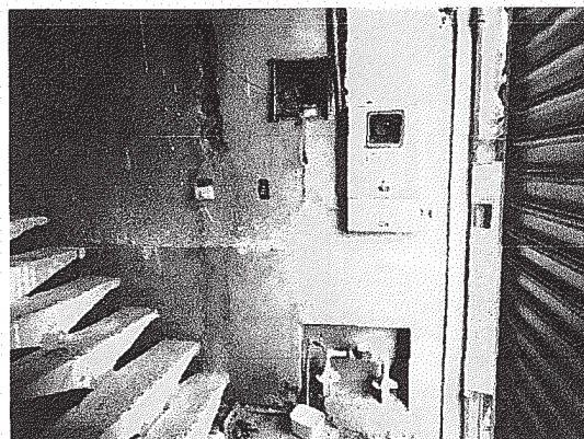
Foto 5: Vista das instalações
