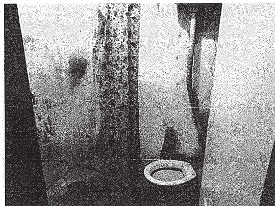
Foto 9: Vista do banheiro – pavimento inferior
