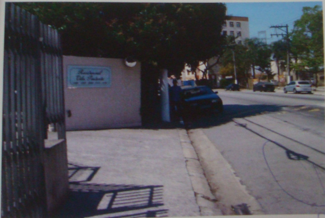
FOTO Nº 02 Vista da Rua Costa Barros à direita do Conjunto Residencial Vila Prudente
