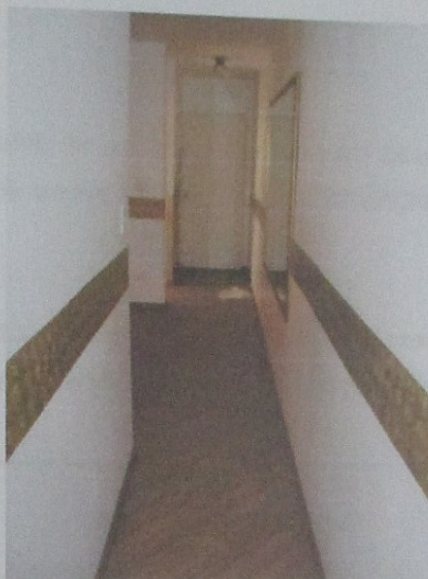
Foto nº 34- Detalhe do corredor de acesso da sala aos dormitórios e banheiro
