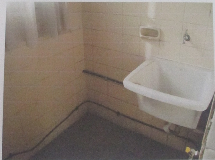
Foto nº 27- Vista parcial da área de serviço
