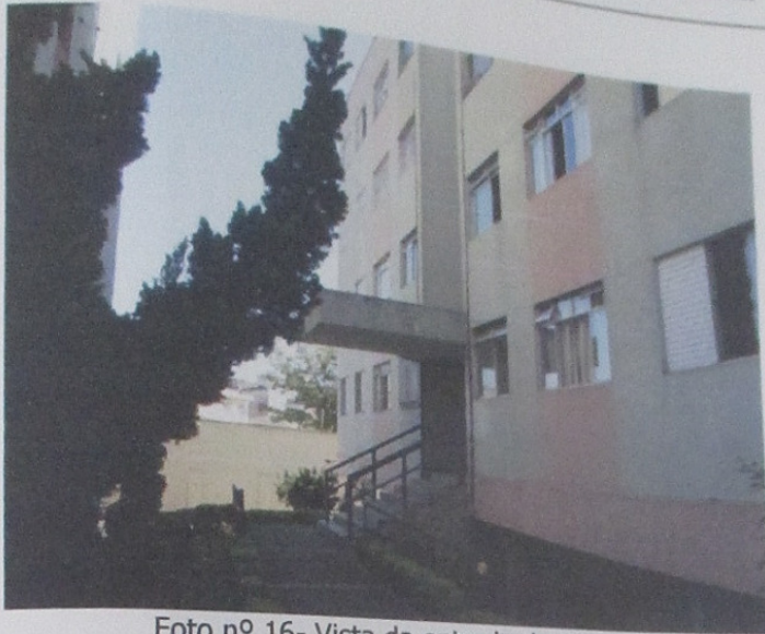
Foto nº 16- Vista da entrada do Bloco A
