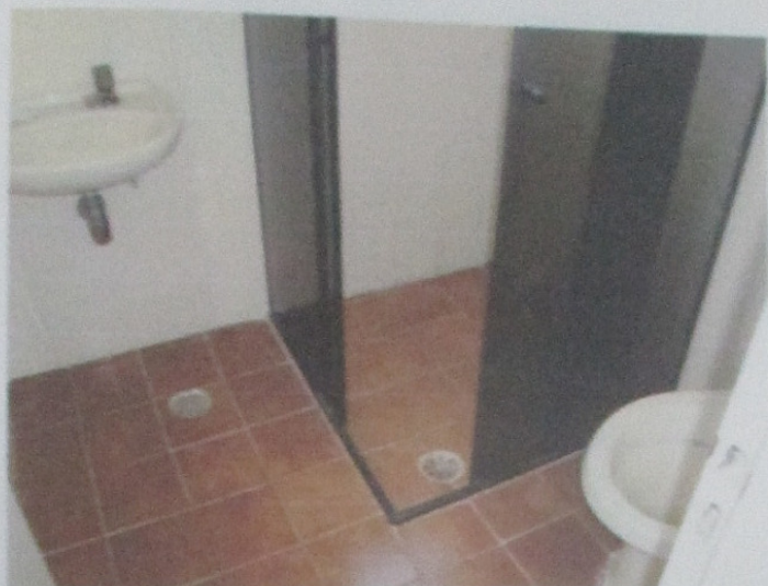
Foto nº 32- Vista parcial do box do banheiro
