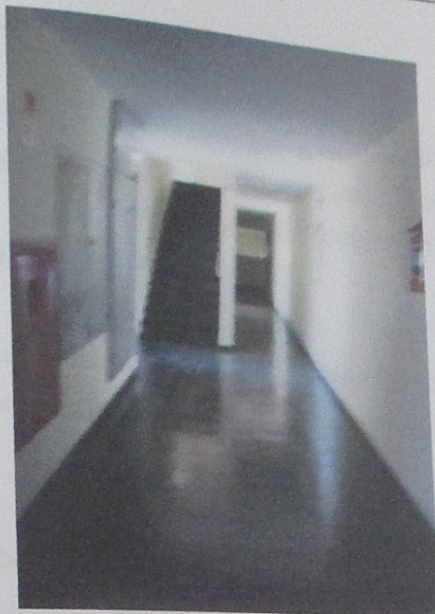
Foto nº 18- Vista dos halls de entrada e de circulação e escadaria no andar térreo
