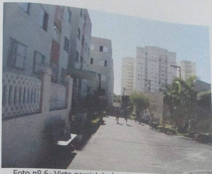
Foto nº 6- Vista parcial da área interna do condomínio
