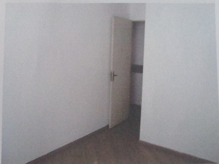
Foto nº 31- Detalhe da entrada do mesmo dormitório
