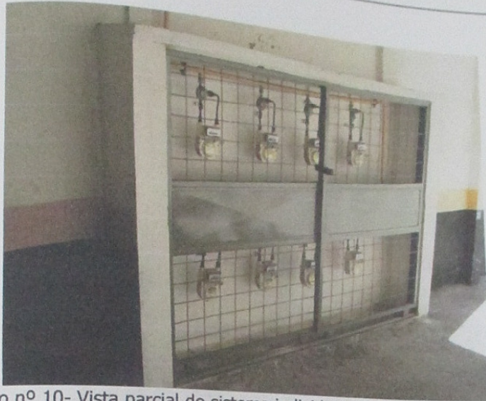
Foto nº 10- Vista parcial do sistema individual de alimentação de gás
