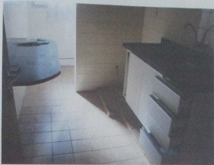
Foto nº 26- Vista parcial da cozinha e da área de serviço
