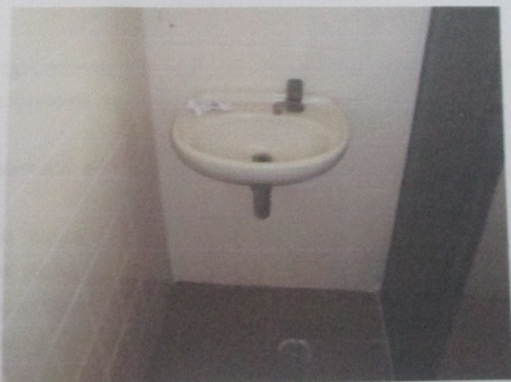
Foto nº 33- Detalhe de aparelho sanitário (pia) do banheiro
