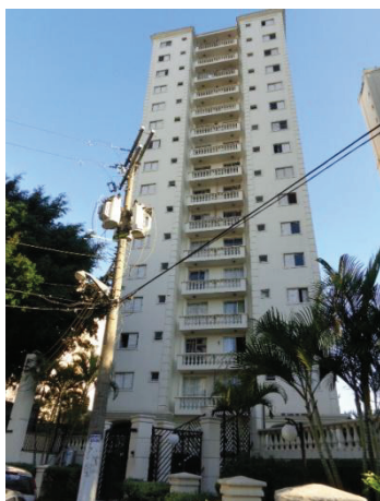
Foto 1 – Fachada do Condomínio
