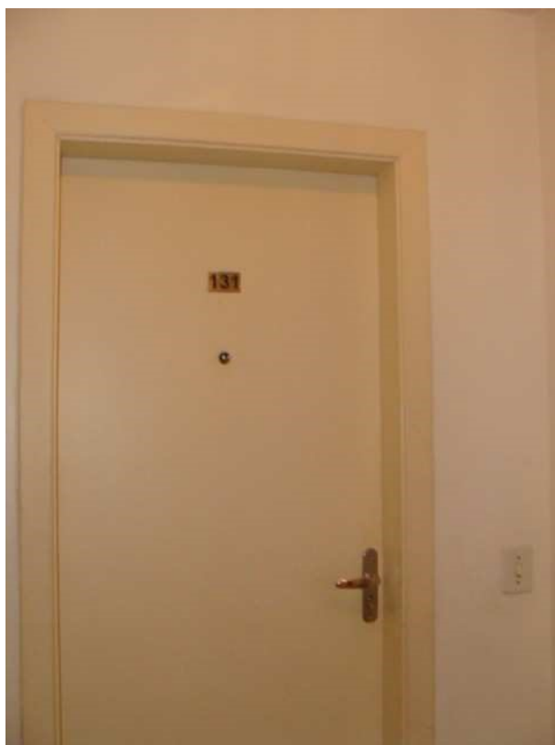
Foto 21. Vista parcial da porta de entrada do apartamento avaliando.
