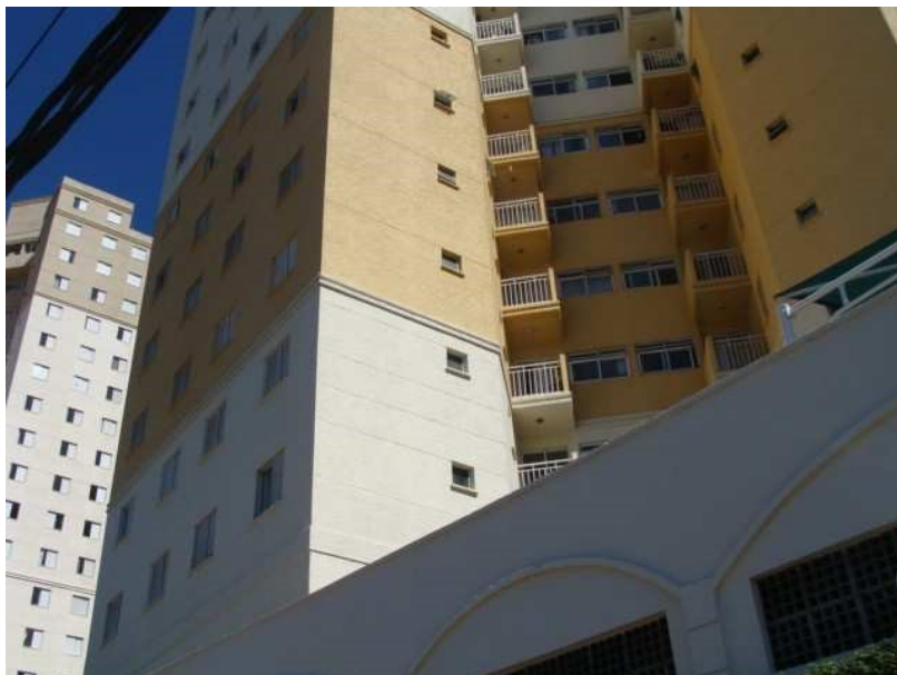
Foto 1. Vista parcial das fachadas das torres do condomínio.
