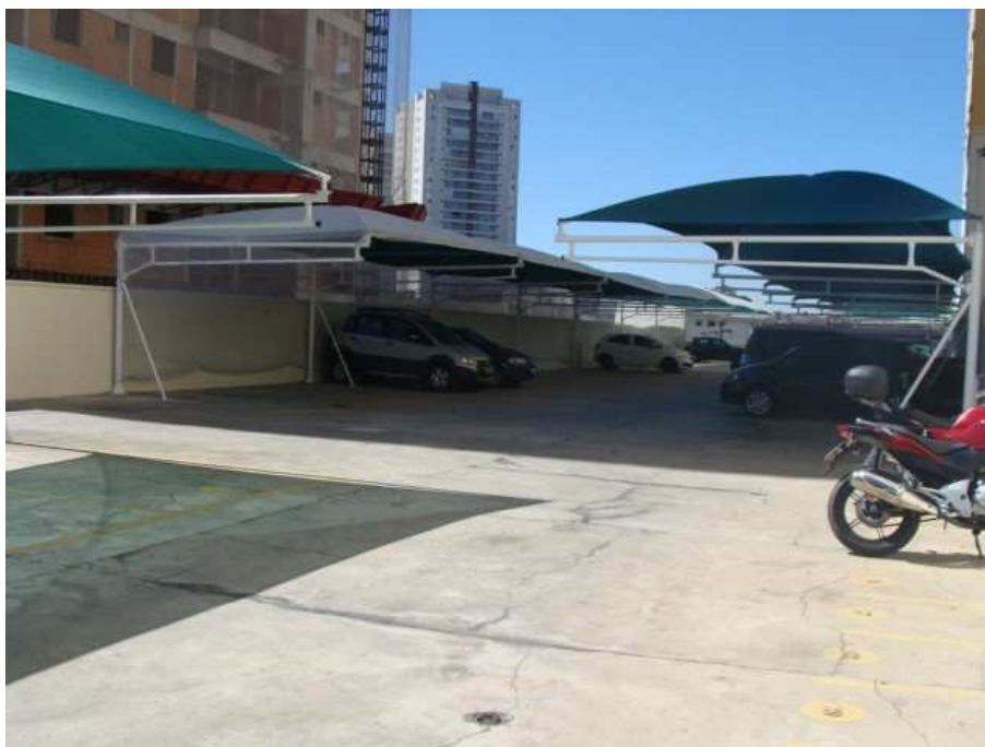
Foto 12. Vista parcial das vagas de garagem localizadas no pavimento térreo.
