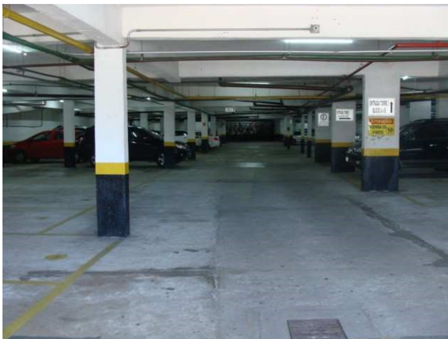
Foto 13. Vista parcial do subsolo.
