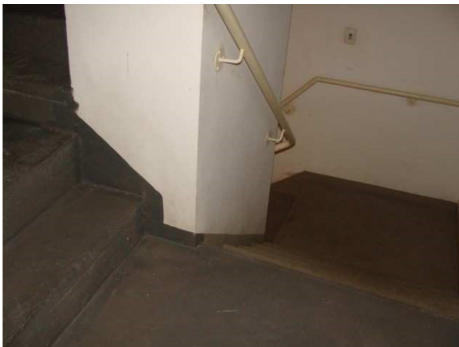
Foto 19. Vista parcial da escada de acesso aos pavimentos da Torre 2.
