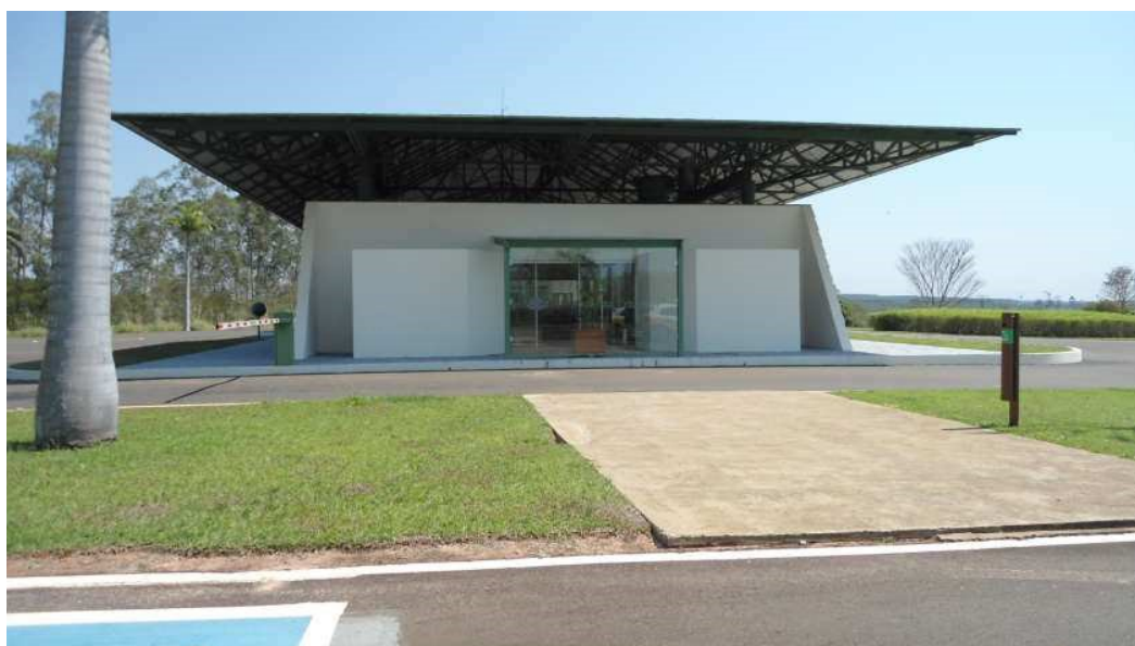
FOTO 03 – Vista da administração do empreendimento
