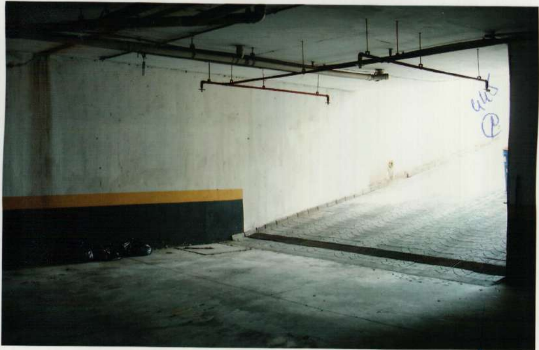
FOTO 24 – VISTA GERAL DO ESTACIONAMENTO NO SUBSOLO.
