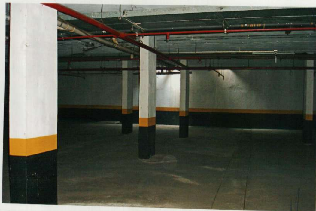
FOTO 26 - OUTRA VISTA DO ESTACIONAMENTO NO SUBSOLO.
