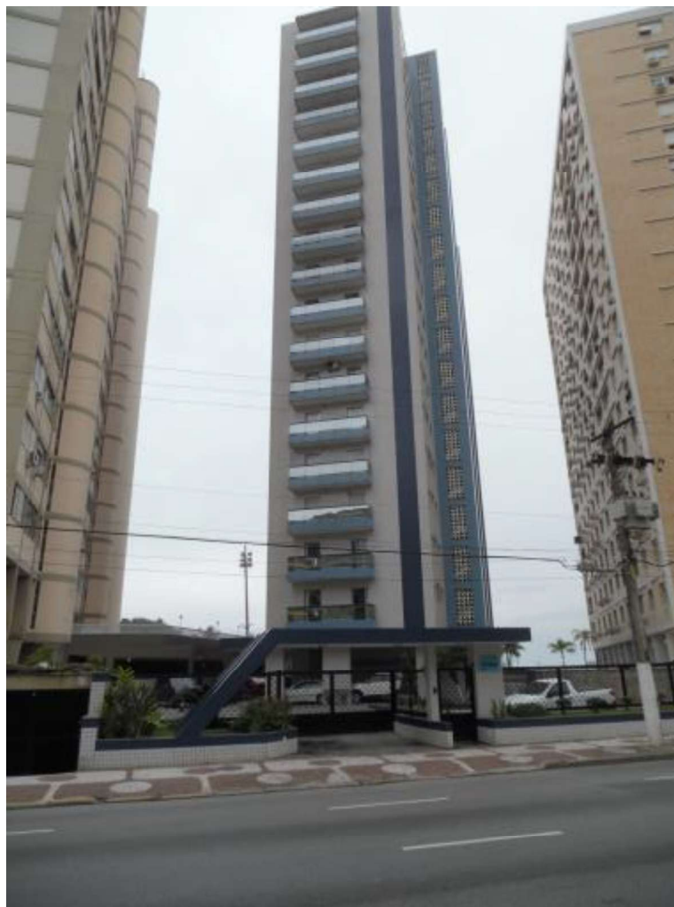
FOTO 01: Vista da fachada do imóvel.
