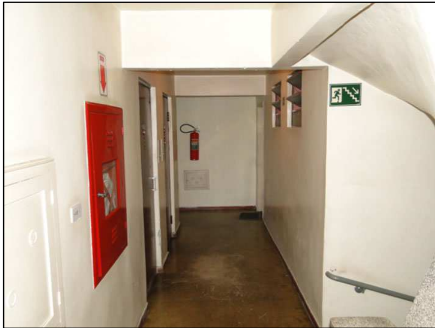
Hall de circulação do 3º andar do Edifício Paulo VI.
