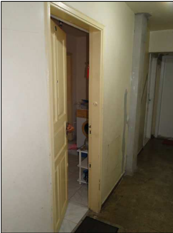
Detalhe da porta do apartamento avaliando.
