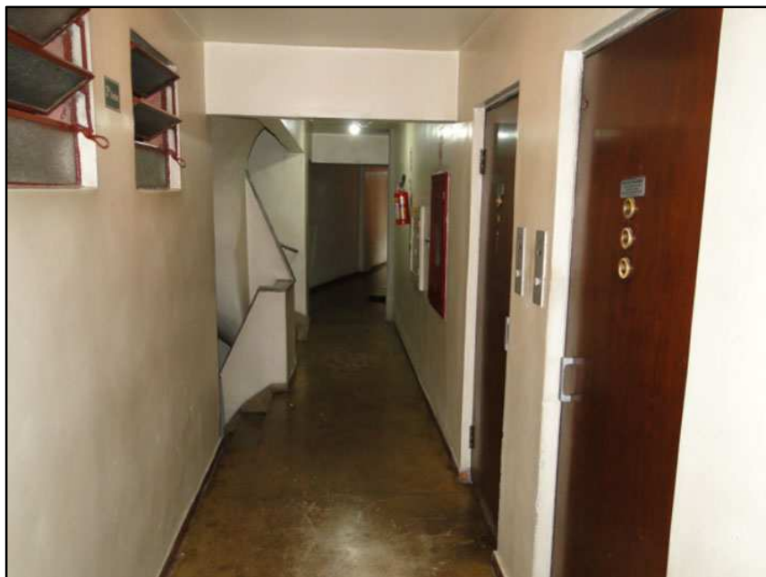
Nova vista do hall de circulação, em frente aos elevadores.
