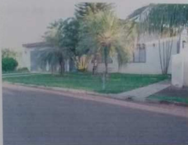
Foto 3 – Outro detalhe frontal do imóvel avaliado
