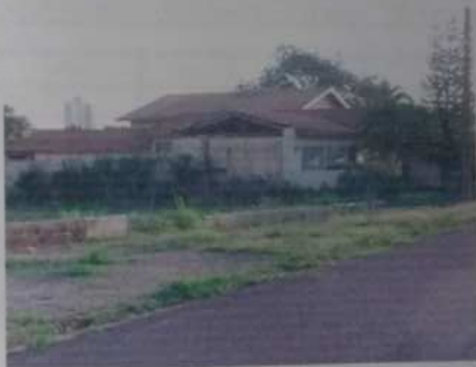
Foto 4 – Vista lateral do imóvel avaliado – Lateral esquerda
