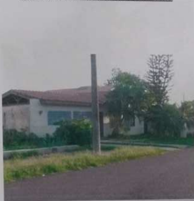
Foto 1 - Vista do imóvel avaliando - Rua Primo Zambianchi, 44
