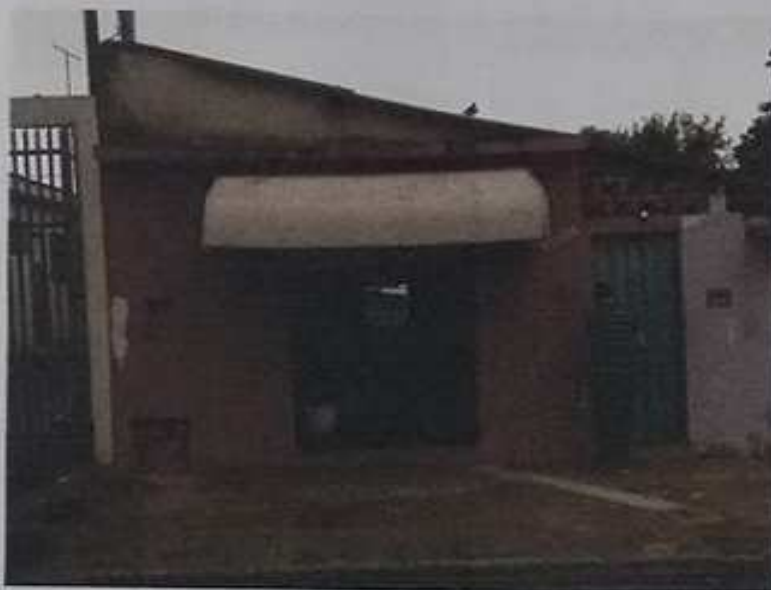
Foto 1 - Vista da fachada do imóvel pela Rua Medeiros de Albuquerque, nº 1658
