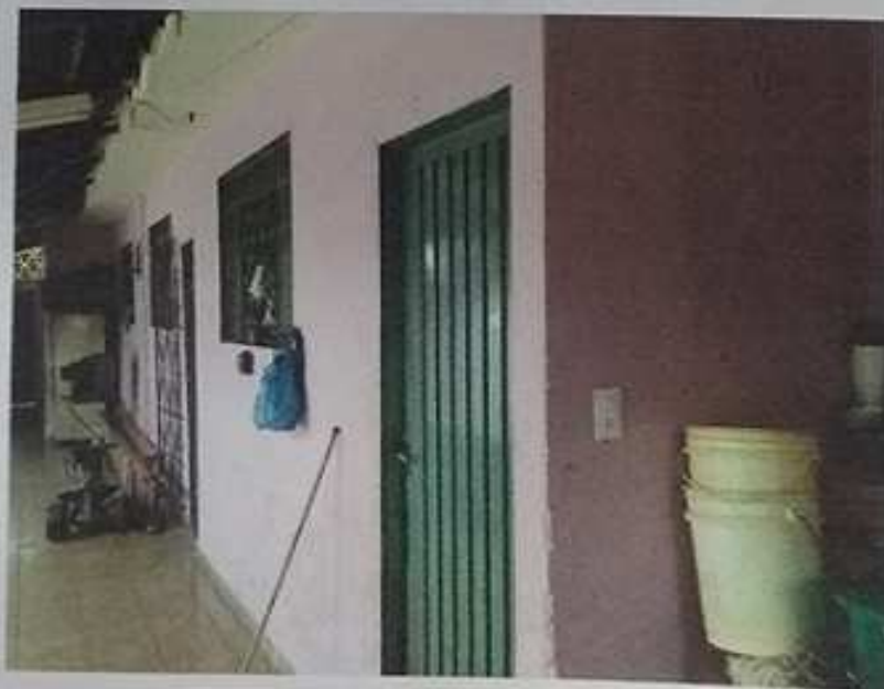
Foto 2 - Vista da área externa do imóvel
