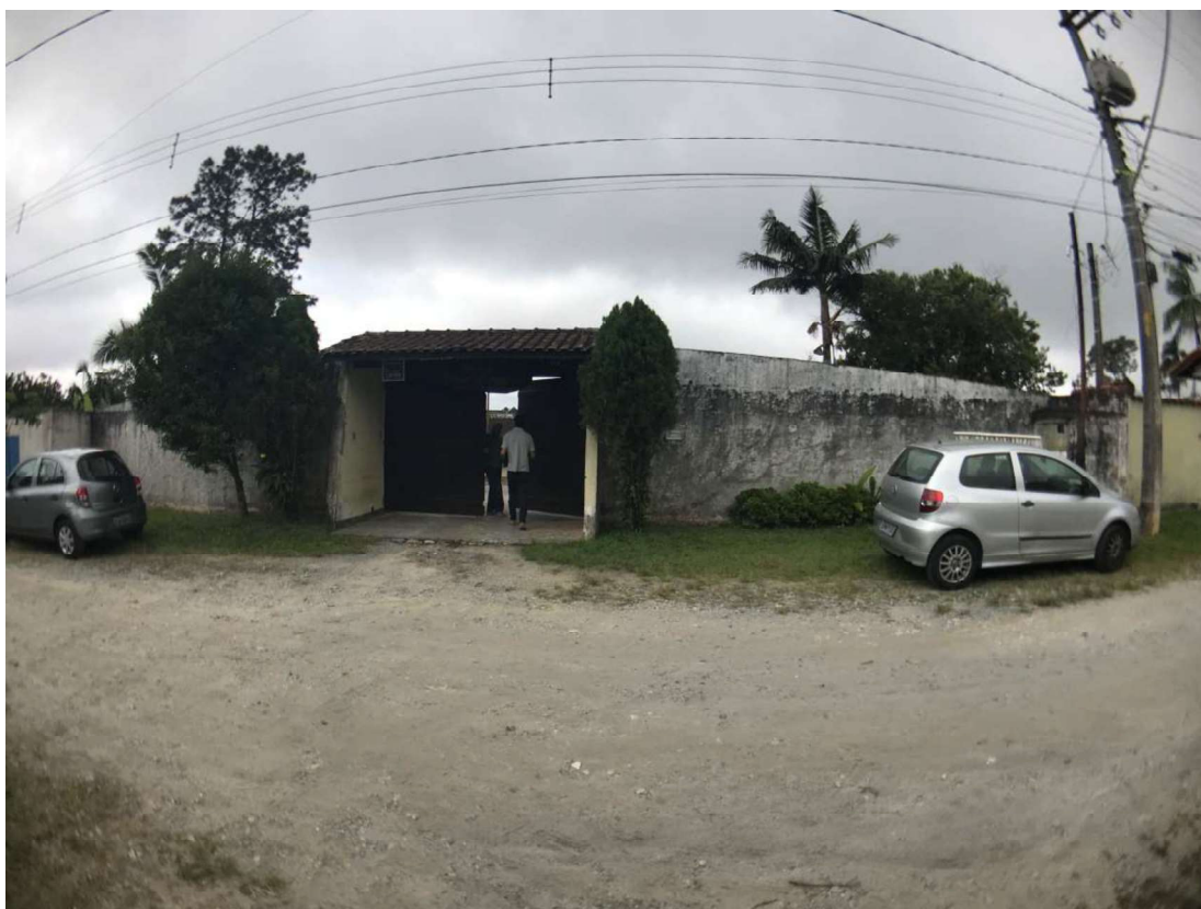
FOTO 01: Vista da fachada da chácara desde Rua Luiza Viezzer Finco.
