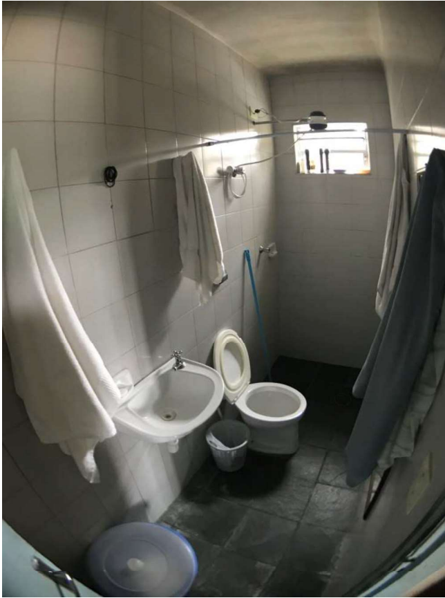
FOTO 53: Vista do banheiro do caseiro.
