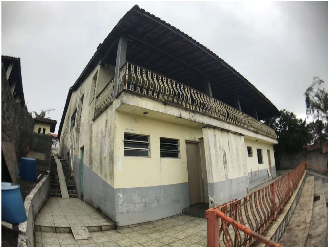
FOTO 42: Vista da fachada posterior da casa.
