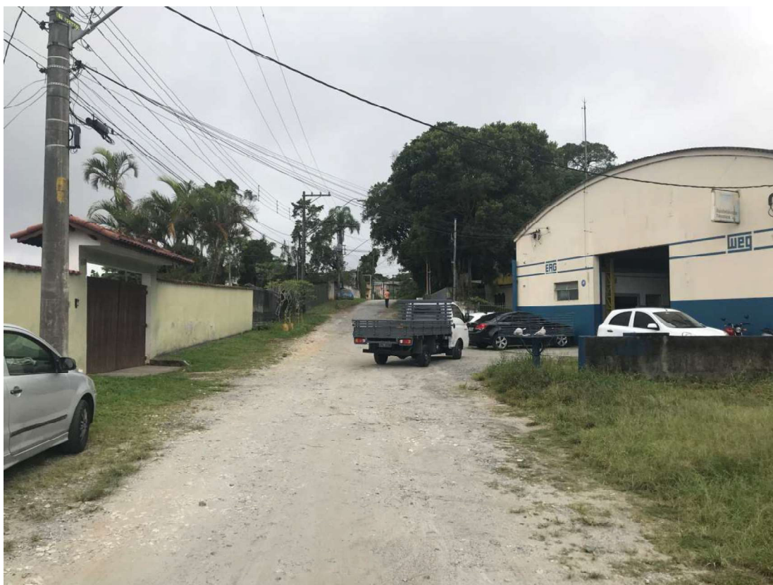
FOTO 02: Vista a partir da Rua Luiza Viezzer Finco sentido sudeste.
