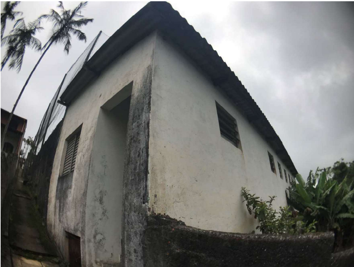
FOTO 62: Vista dos vestiários do campo.
