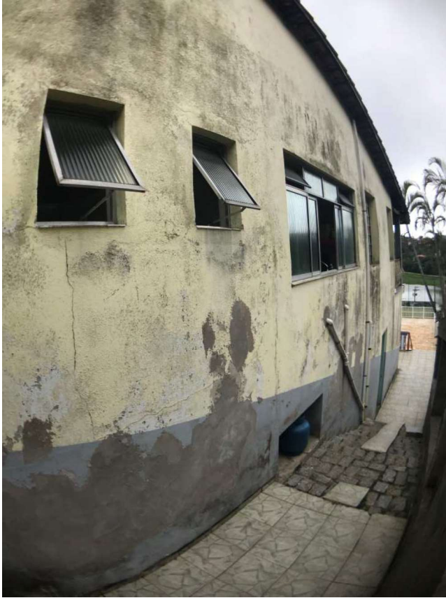
FOTO 39: Vista da fachada lateral direita da casa.
