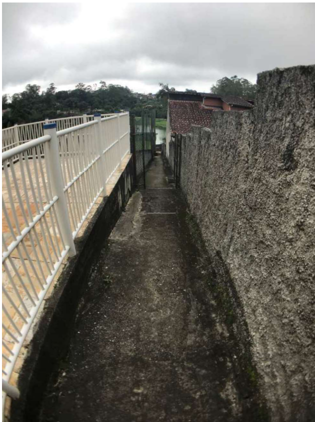
FOTO 58: Vista da rampa lateral, entre piscinas e campo.
