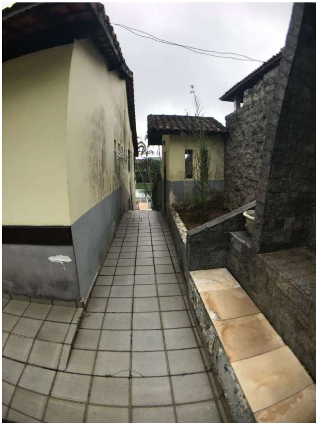
FOTO 36: Vista do corredor lateral direito.
