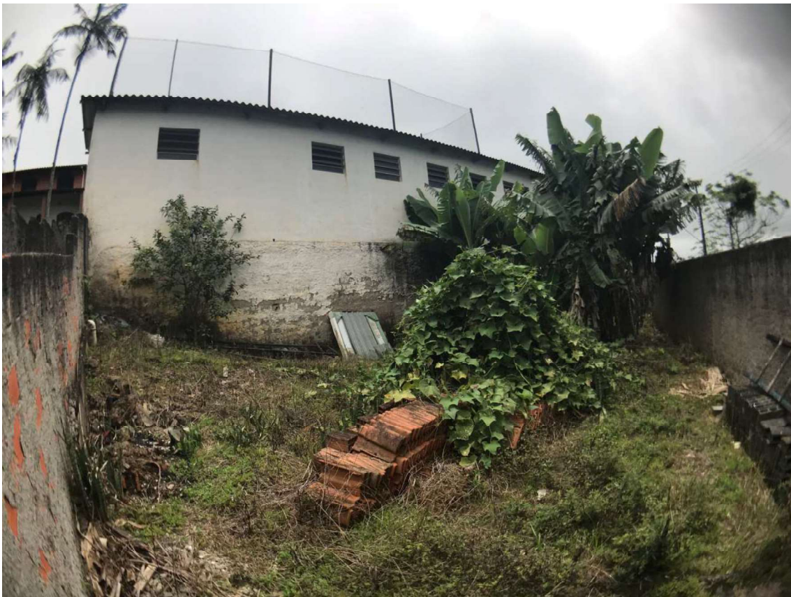
FOTO 70: Vista da fachada dos vestiários e espaço livre nos fundos do lote.
