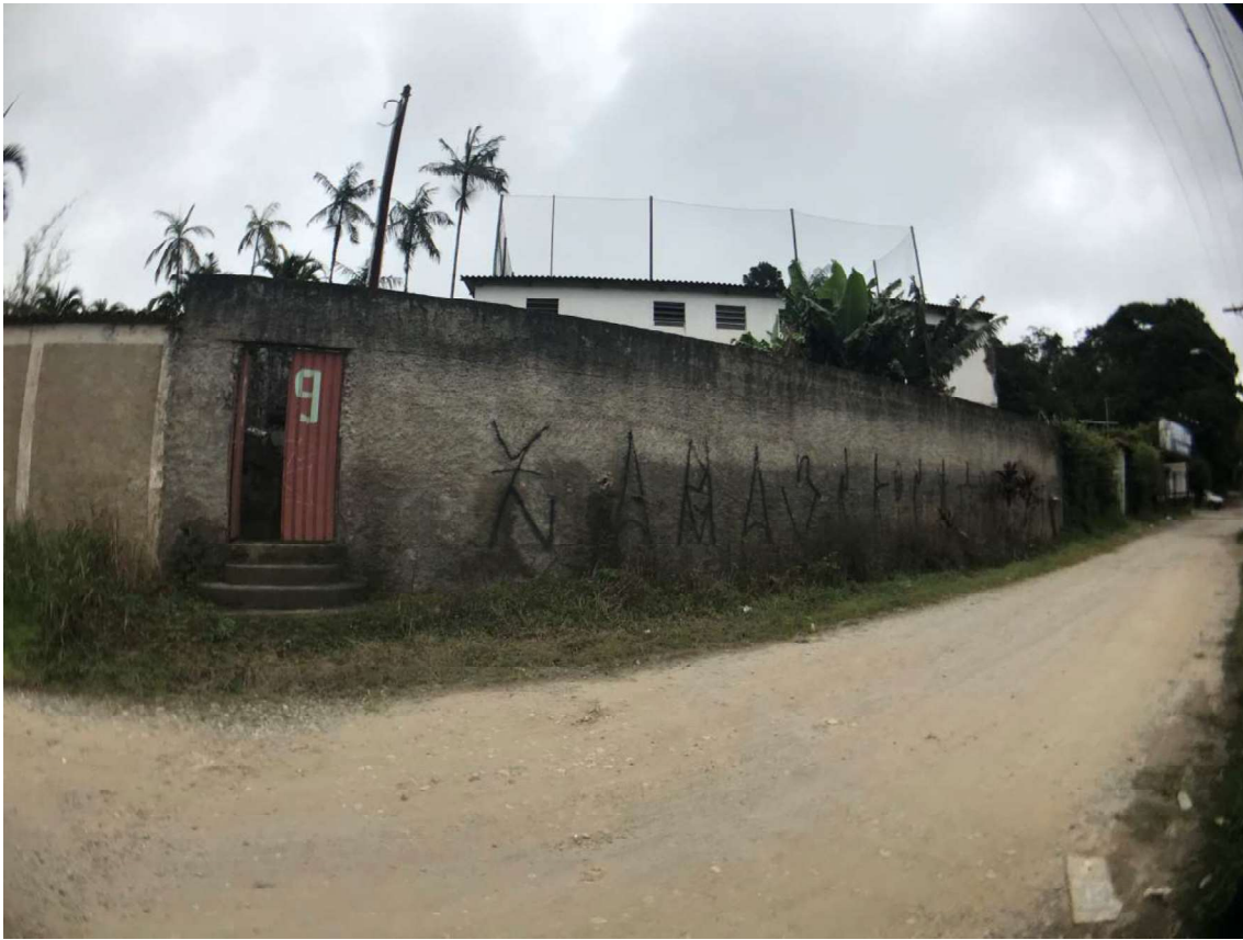
FOTO 71: Vista do muro sobre Avenida Coração Eucarístico de Jesus.
