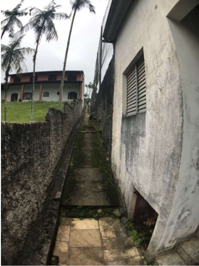
FOTO 61: Vista da rampa lateral desde os vestiários do campo de futebol.
