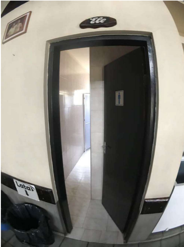
FOTO 25: Vista da entrada do banheiro masculino.
