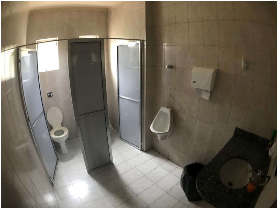
FOTO 26: Vista do banheiro masculino.
