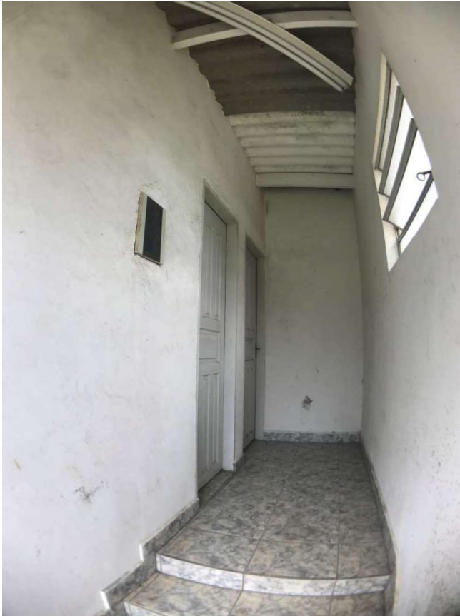
FOTO 63: Vista da entrada dos vestiários do campo.
