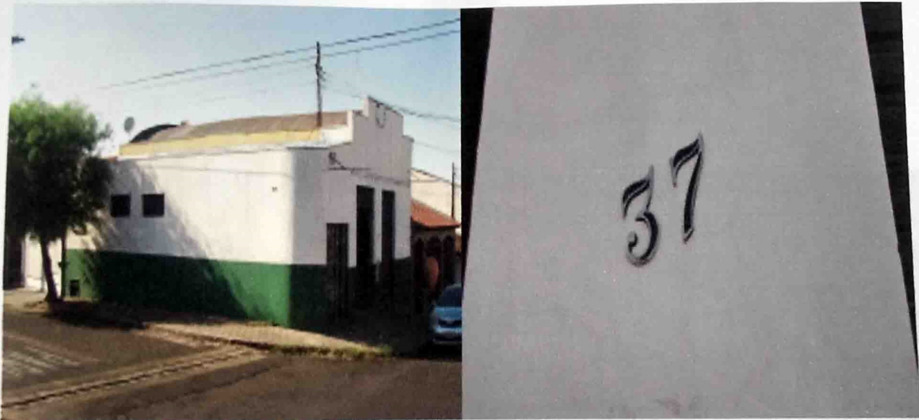
Imóvel: Fachada e identificação.
