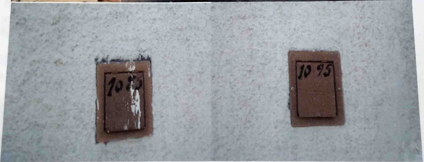
Fachada e identificação.
