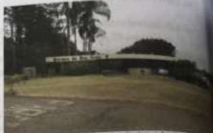
Portaria do Condomínio Quinta da Boa Vista B
