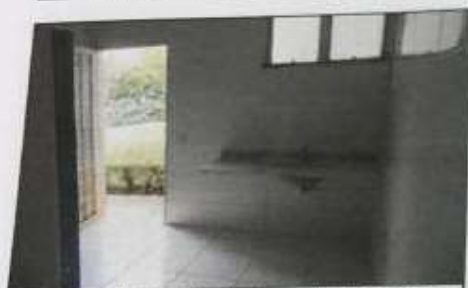
Sanitário/Vestiário da área complementar
