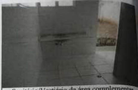
Sanitário/Vestiário da área complementar
