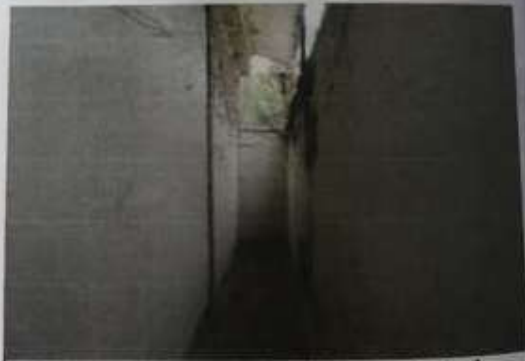
Recuo lateral da edificação principal
