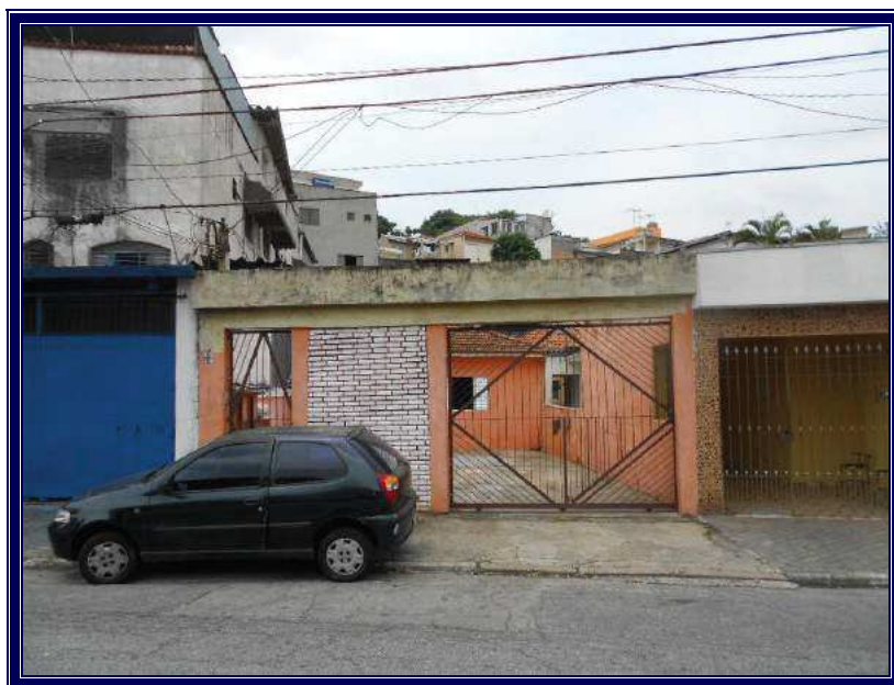
Vista da frente do imóvel avaliando.
