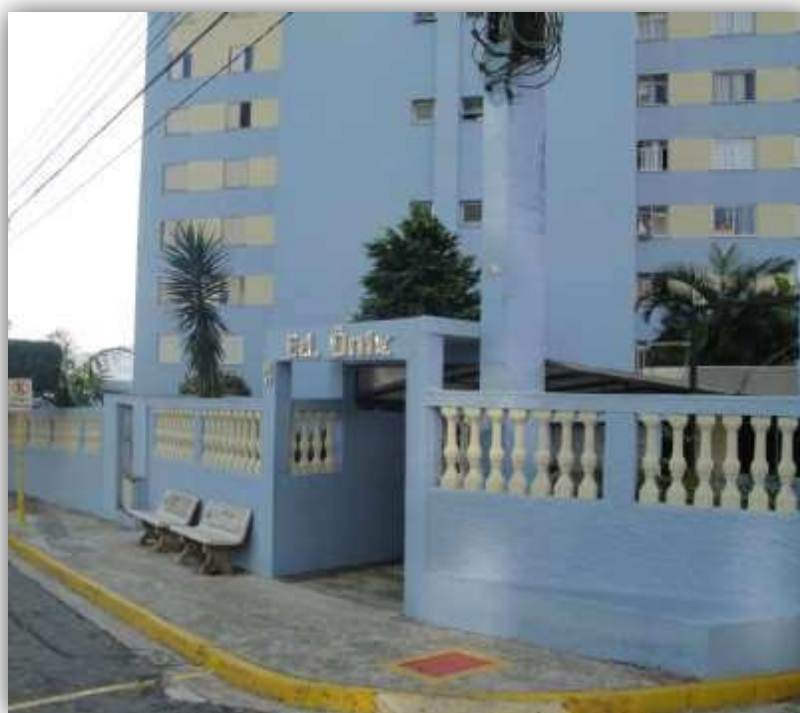
Vista Edifício Ônix – Bloco 17
