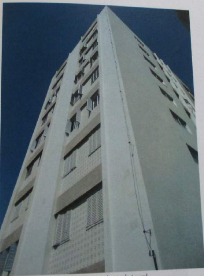
Fachada de fundos e lateral
