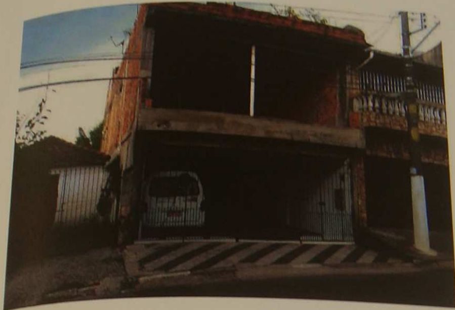
FOTO N° 01: Vista da fachada do imóvel avaliando, localizado na Jonh Speers n° 158 – Vila Carmozina – São Paulo/SP.
