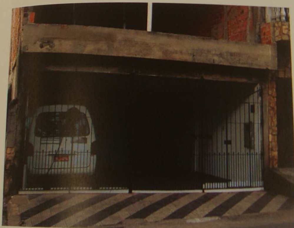
FOTO N° 04: Vista da parte inferior da fachada do imóvel avaliando.
