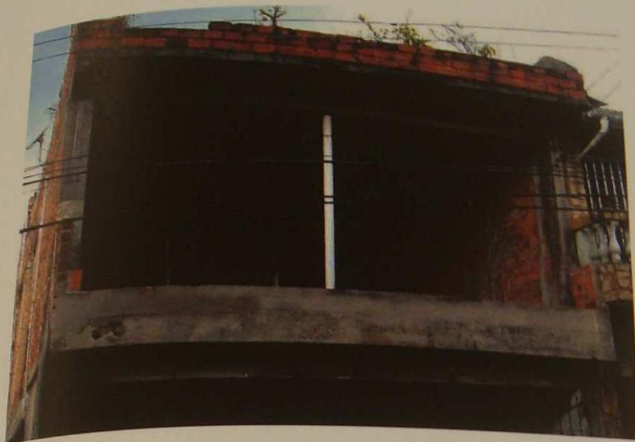
FOTO N° 03: Vista da parte superior da fachada do imóvel avaliando.
