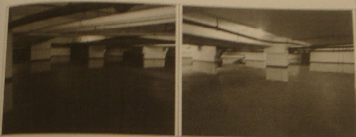
Fotos 21 e 22: Vistas gerais da garagem do subsolo
