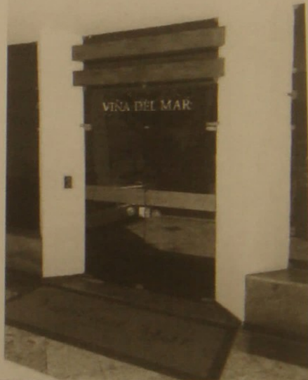
Foto 10: Acesso de pedestres ao interior do edifício Viña Del Mar.
