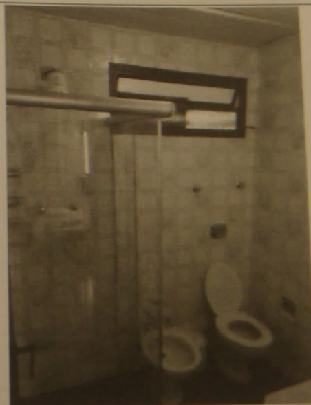
Foto 42: Vista interna do banheiro social.
