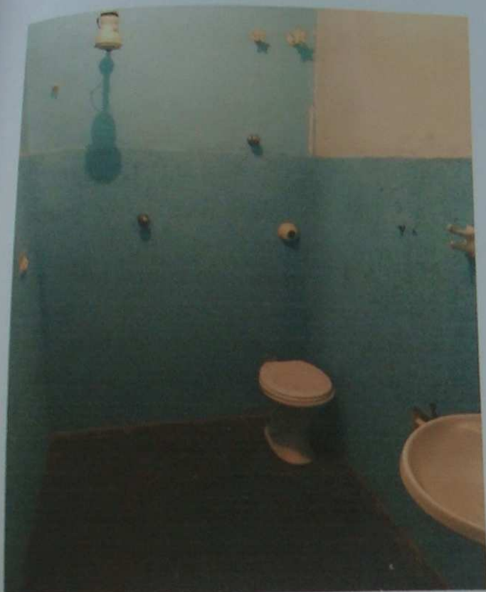
Banheiro do Apartamento n° 64.
