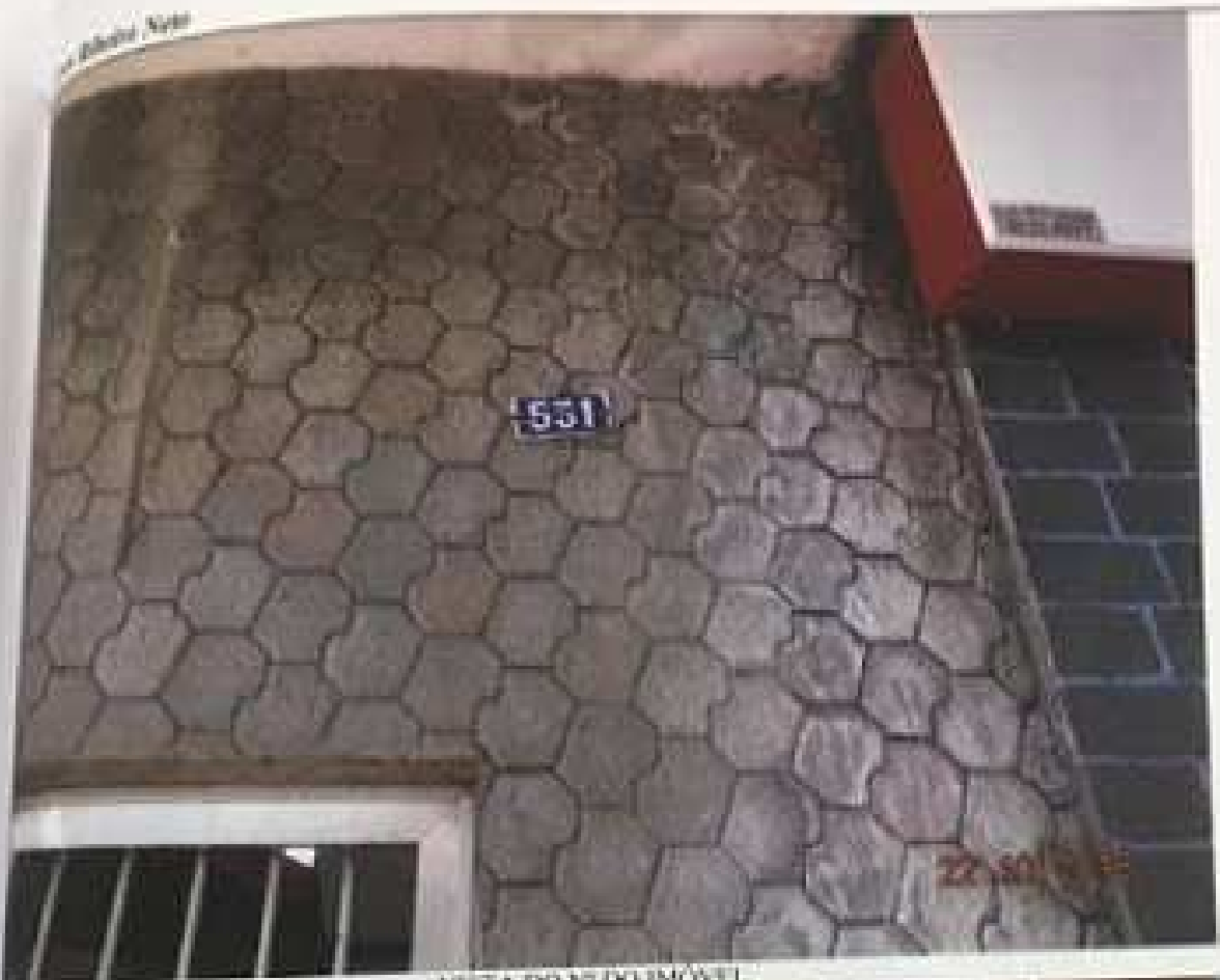
VISTA DO Nº DO IMÓVEL.
