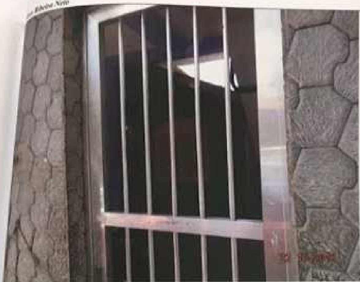
VISTA DO PORTÃO DE ENTRADA
